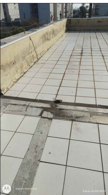
PISO E REBOCO TERRAÇO
