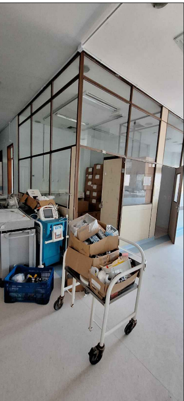
DIVISÓRIAS ISOL. UTI
