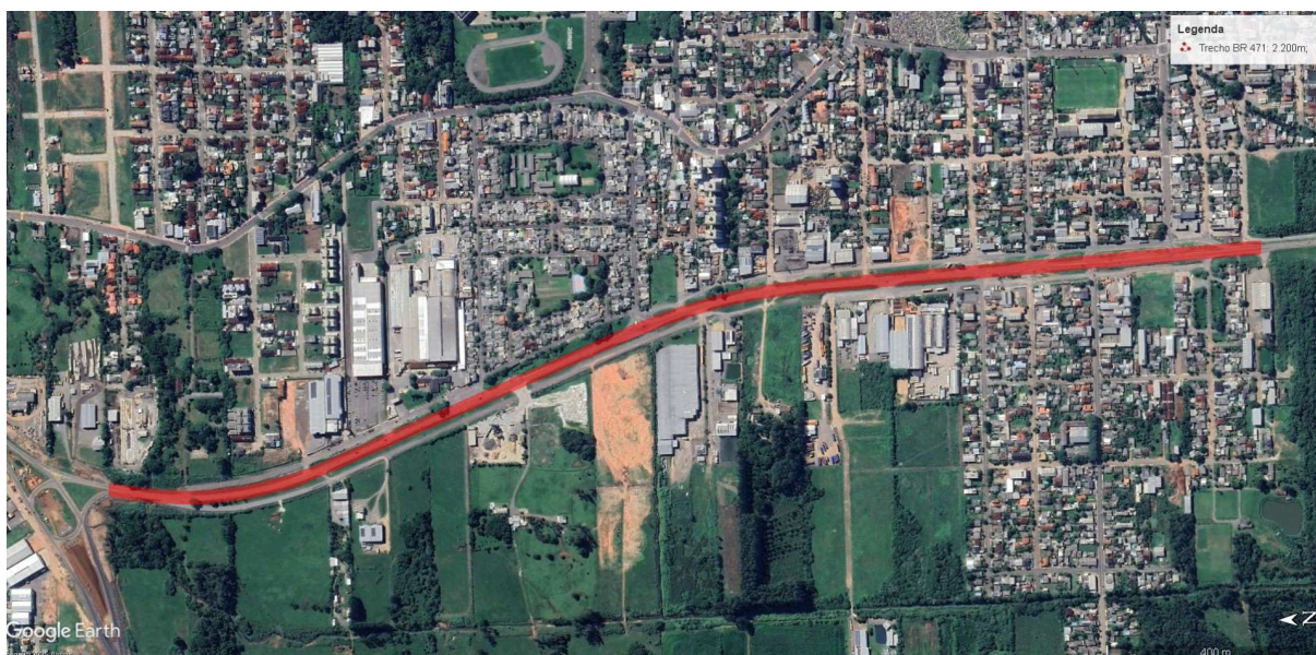
Imagem 1 – Localização e trecho da Obra
