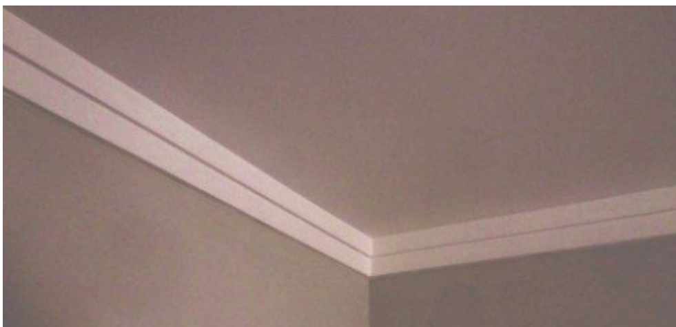
roda forro de gesso junto aos forros de concreto
