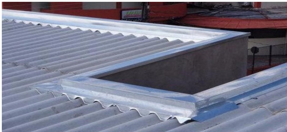
rufo em peça única - topo da platibanda com pingadeira e cobrindo a junção com as telhas
