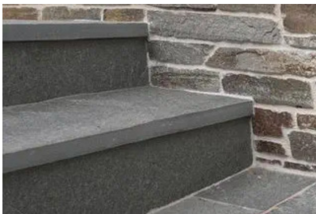
peças de ardósia da base dos degraus com balanço
