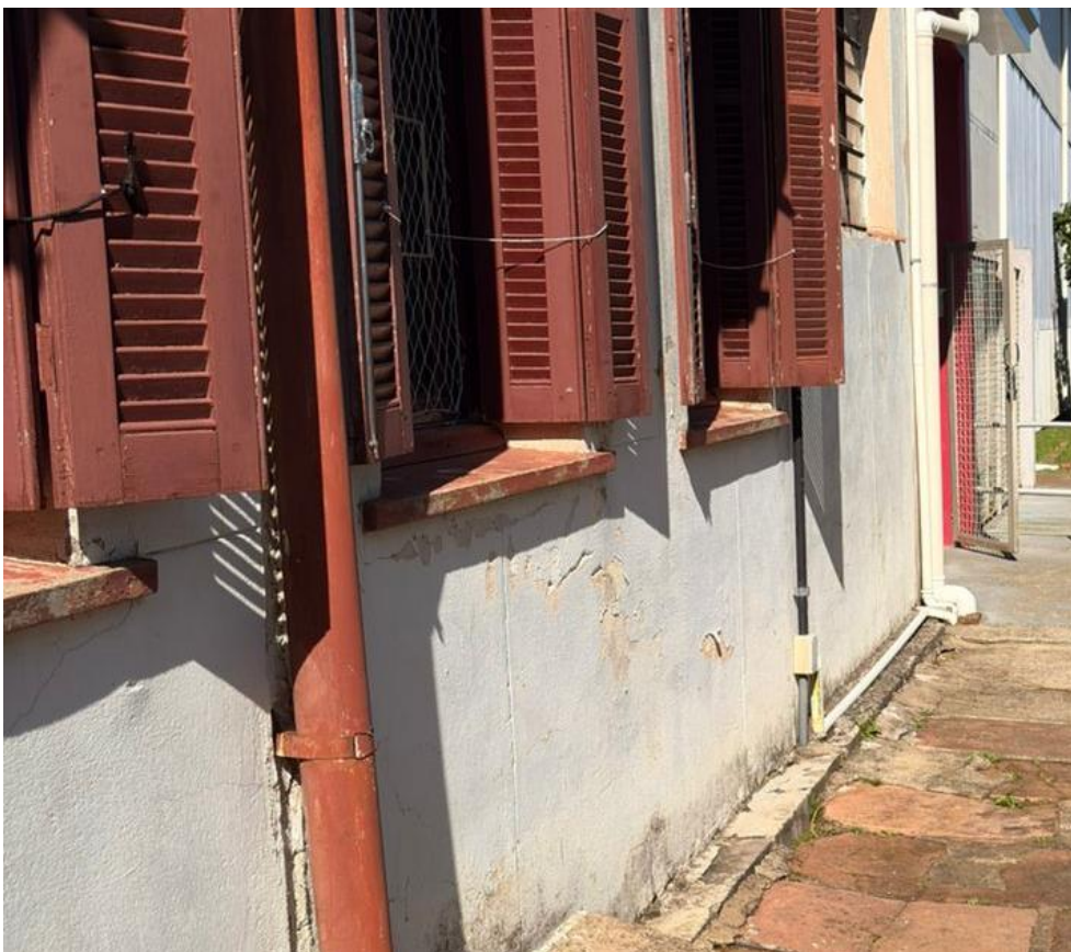
Figura 38 – Foto atual das esquadrias existentes na fachada Noroeste da Escola (modelo de pingadeira em concreto a ser executada)
