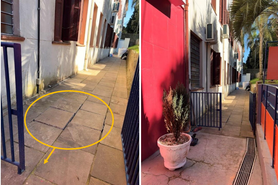
Figura 1 e 2 – Local existente onde será executado o trecho de tubulação
