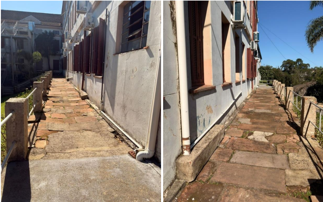
Figuras 13 e 14 – Fotos atuais do corredor lateral da Escola
