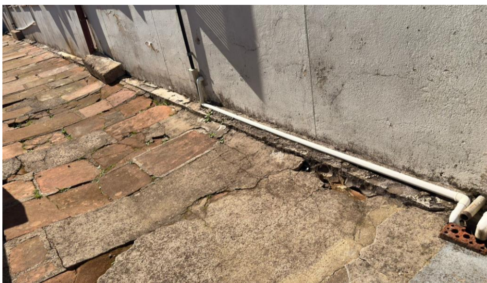
Figuras 12 – Foto atual das tubulações existentes
