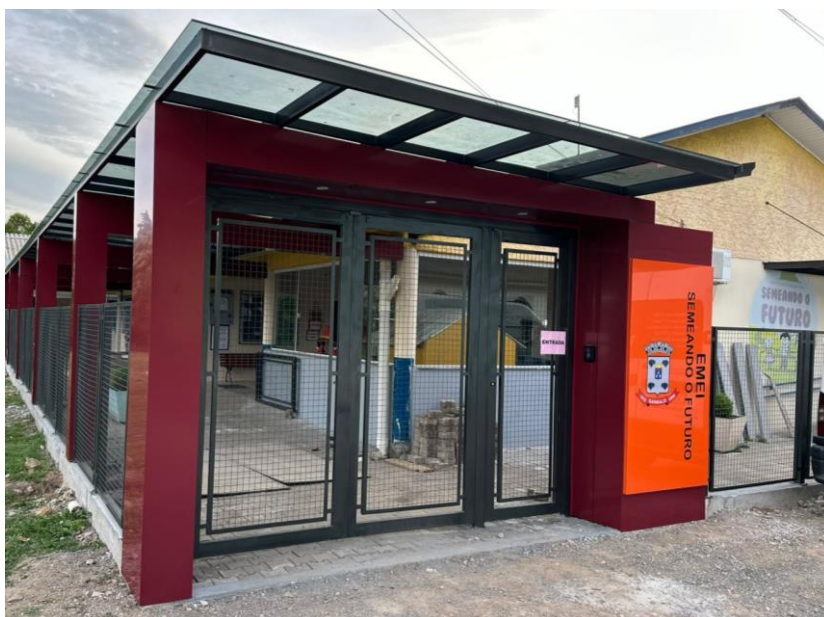
Figura 18 – Imagem de referência de cercamento executado em Escola do Município
