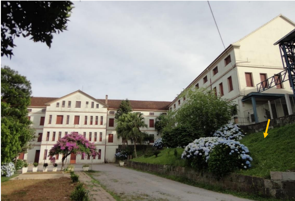
Figura 4 – Local existente onde será instalada a fossa/filtro
