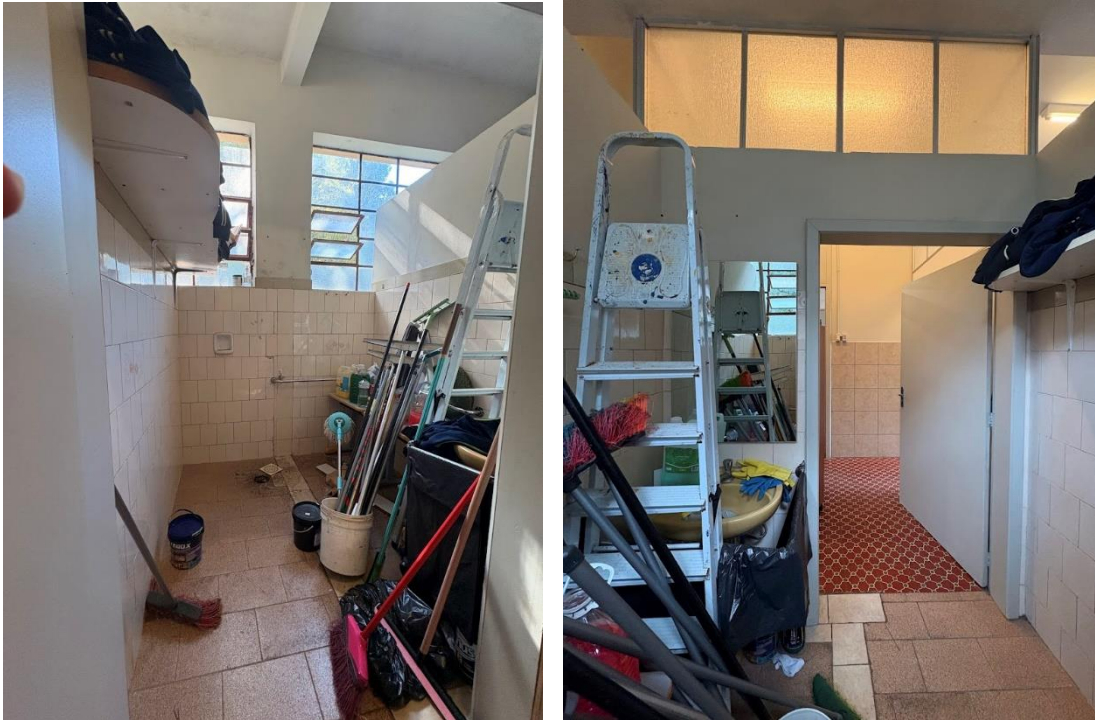
Figuras 28 e 29 – Fotos atuais do sanitário PNE do segundo pavimento
