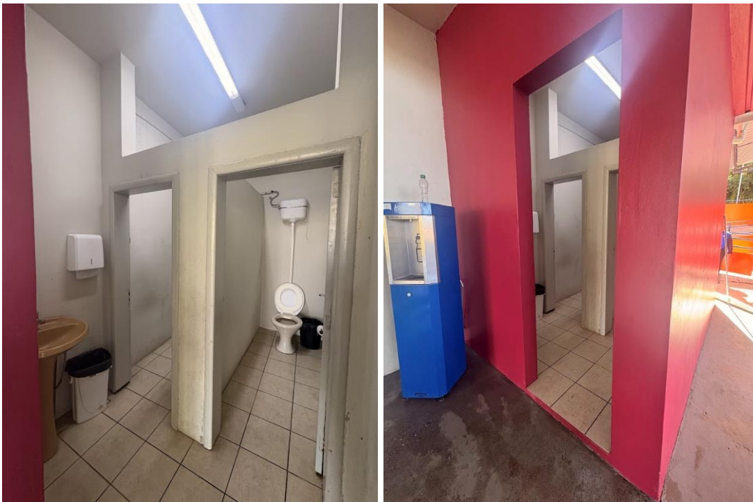
Figura 8 e 9 – Fotos atuais do sanitário externo
