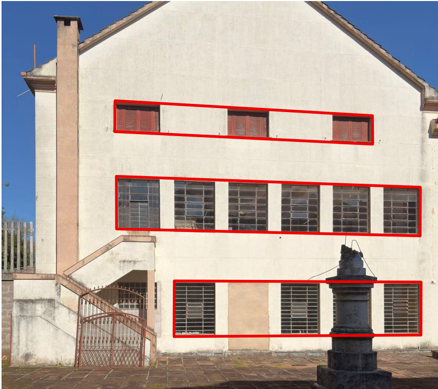
Figura 39 – Foto atual da fachada Noroeste, onde serão substituídas as esquadrias
