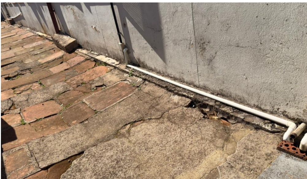
Figuras 12 – Foto atual das tubulações existentes
