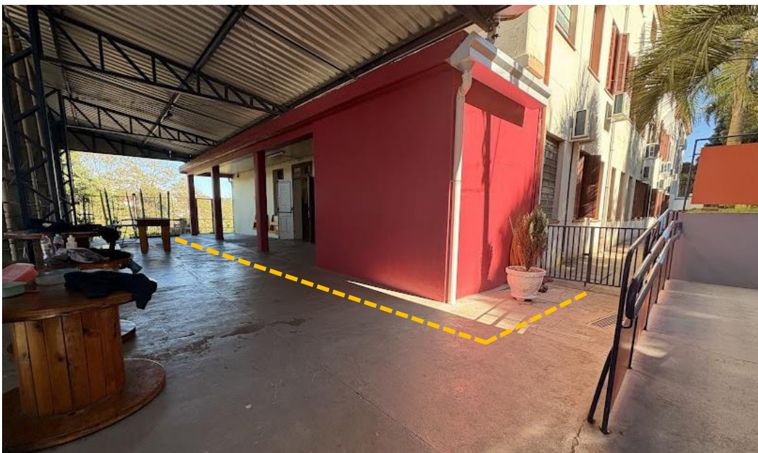
Figura 3 – Local existente onde será executado o trecho de tubulação
