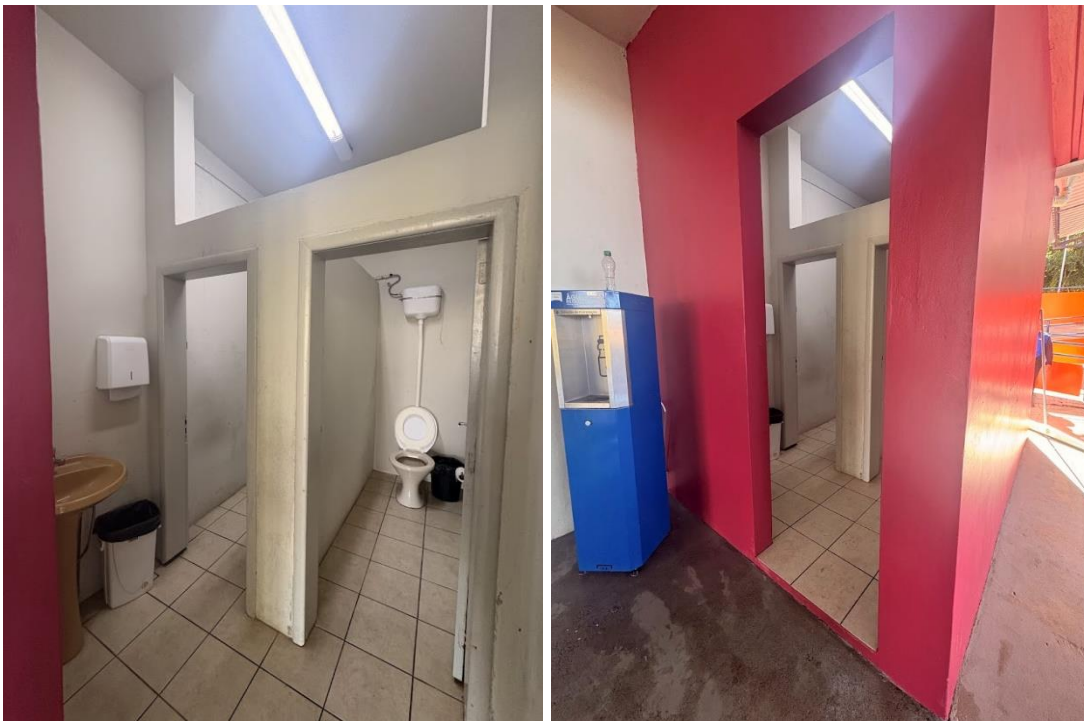
Figura 8 e 9 – Fotos atuais do sanitário externo
