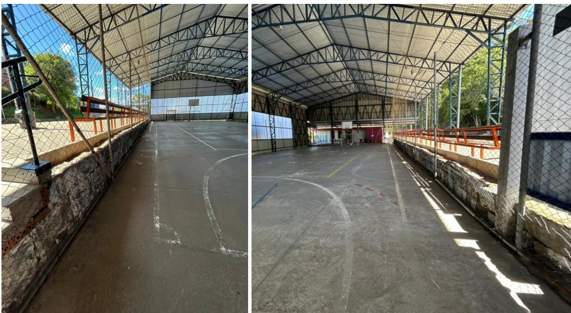
Figuras 15 e 16 – Fotos atuais da quadra onde será executada a drenagem
