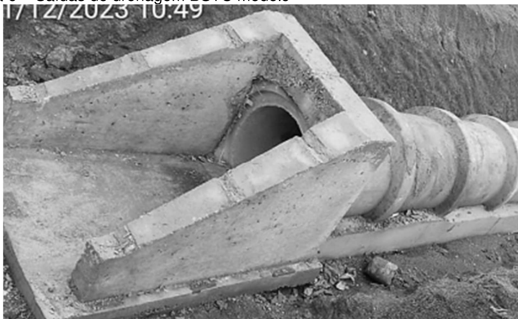
Figura 6 – Saídas de drenagem BSTC modelo
