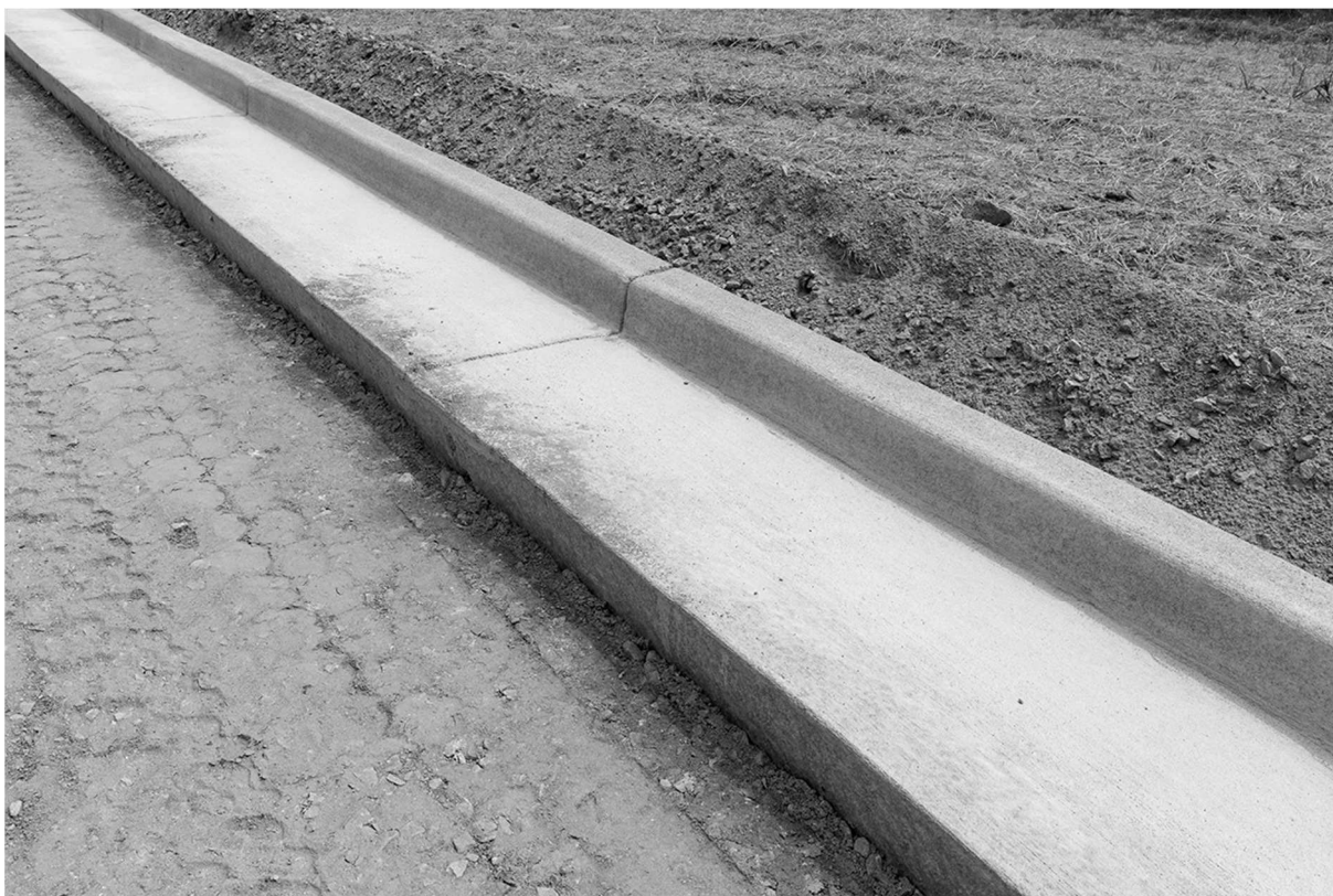
Figura 3 – Modelo de sarjeta com guia triangular
