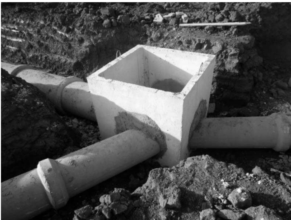
Figura 4 – Modelo de caixa de inspeção
