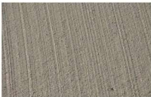
Figura 10 – Aspecto de superfície texturizada transversalmente por vassouramento mecânico.
