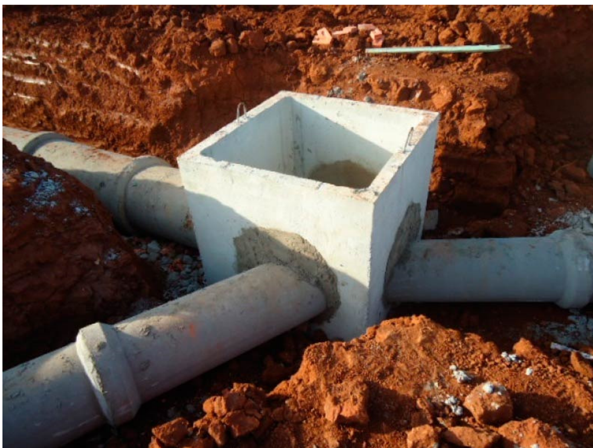
Figura 4 – Modelo de caixa de inspeção
