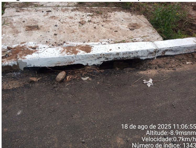
Imagem de boca de lobo com bloqueio parcial de CBUQ
