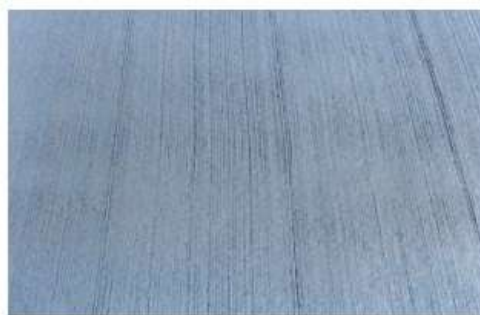
Figura 11 – Aspecto de superfície texturizada transversalmente por vassouramento manual.
