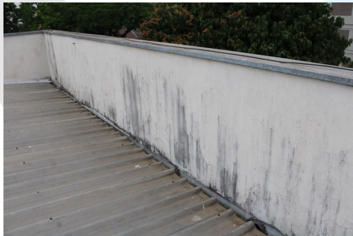
Foto 72 - Atual situação da cobertura 2.
