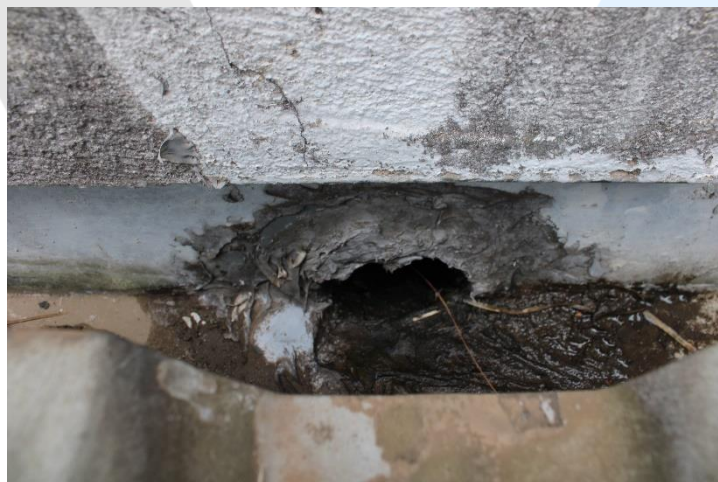
Foto 69 - Atual situação da cobertura 2.
