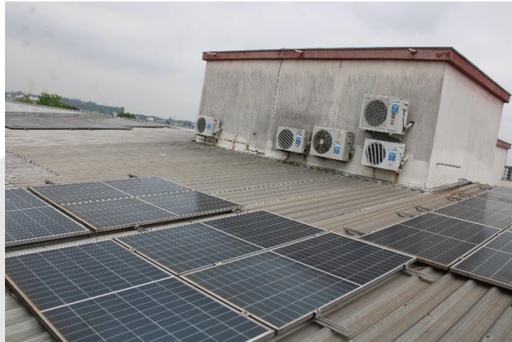
Foto 25 - Atual situação da cobertura 1.
