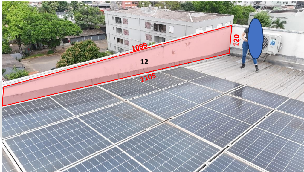
Foto 48 – Medidas da platibanda 12 em cm.
