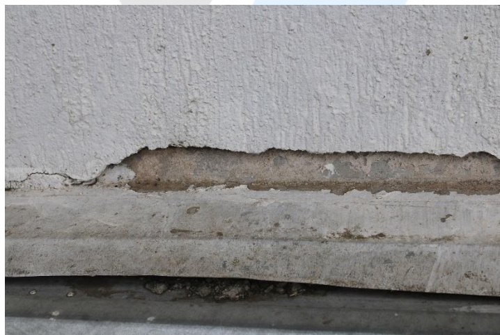
Foto 82 - Atual situação da cobertura 2.
