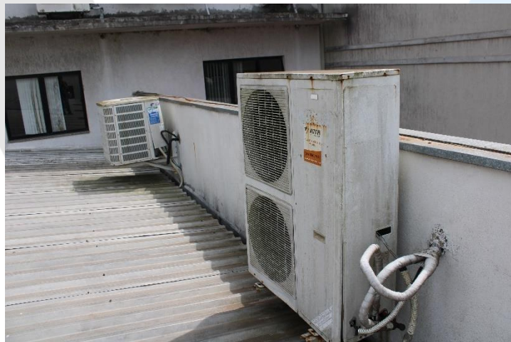
Foto 81 - Atual situação da cobertura 2.
