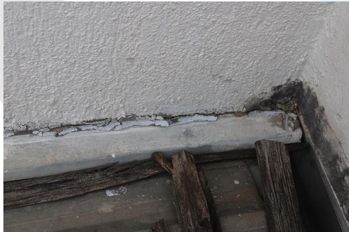
Foto 14 - Atual situação da cobertura 1.
