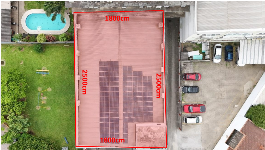
Foto 86- Perímetro da cobertura 2.
