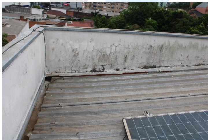
Foto 18 - Atual situação da cobertura 1.
