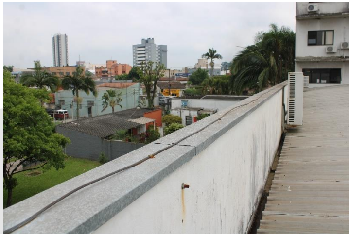
Foto 74 - Atual situação da cobertura 2.
