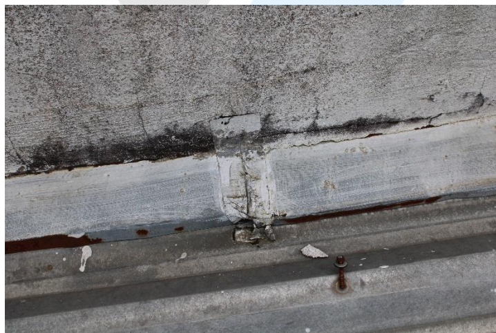
Foto 21 - Atual situação da cobertura 1.
