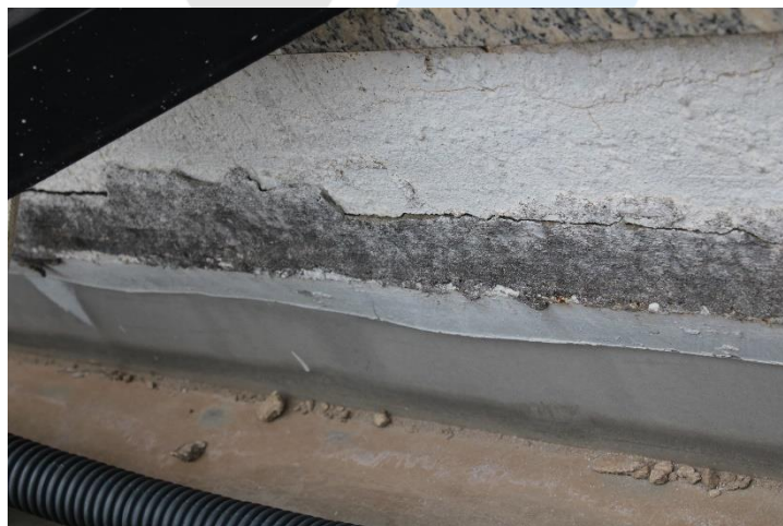
Foto 33- Atual situação da cobertura 1.
