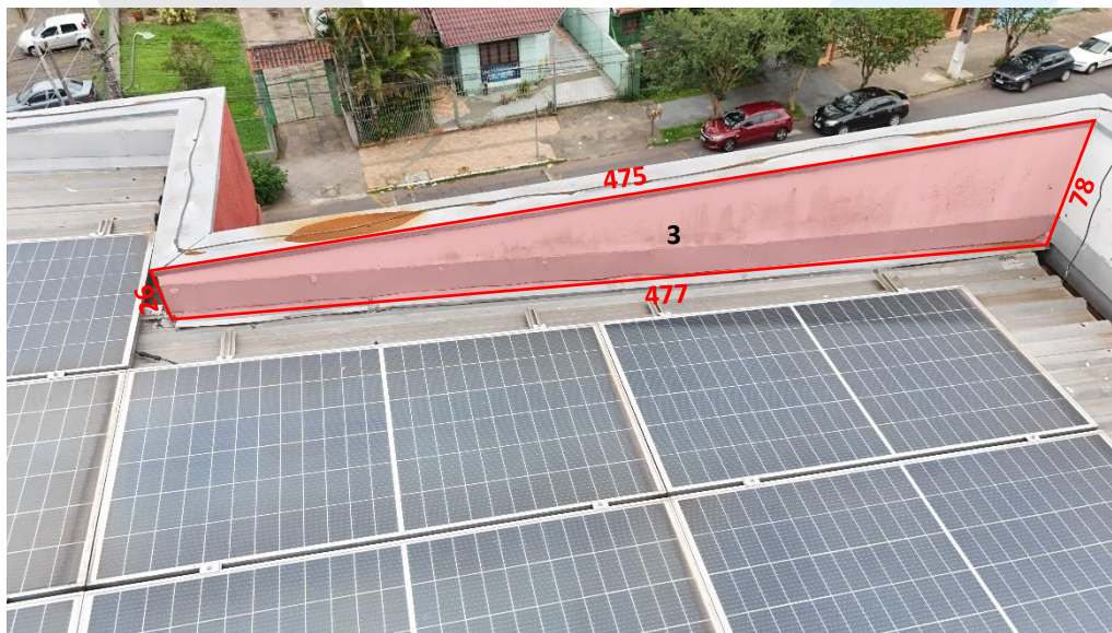
Foto 39 – Medidas da platibanda 3 em cm.
