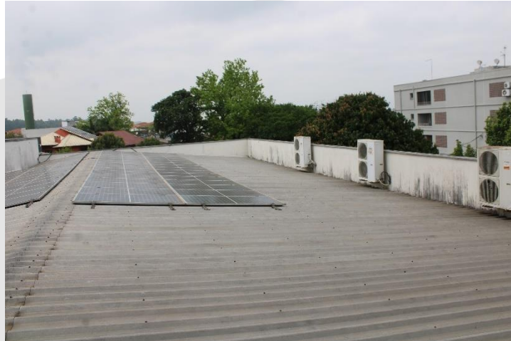
Foto 68 - Atual situação da cobertura 2.
