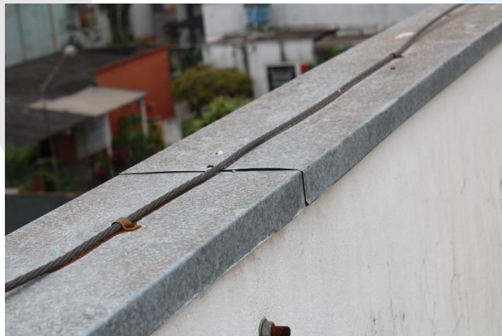
Foto 75 - Atual situação da cobertura 2.
