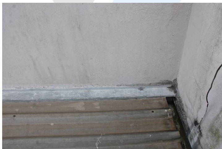
Foto 76 - Atual situação da cobertura 2.
