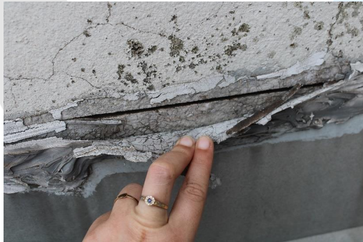
Foto 32- Atual situação da cobertura 1.
