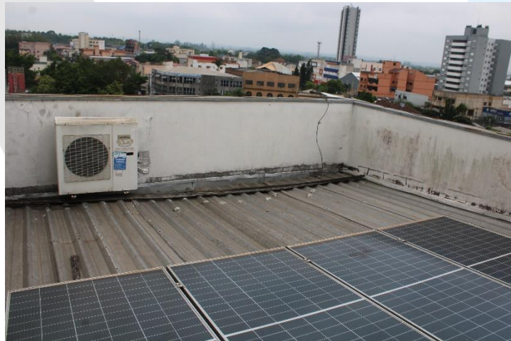
Foto 11 - Atual situação da cobertura 1.
