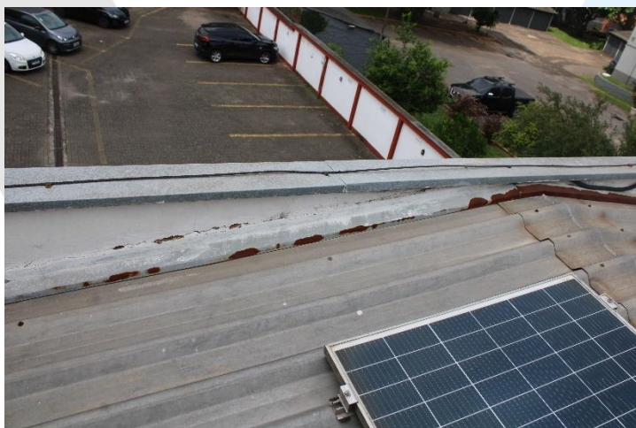
Foto 78 - Atual situação da cobertura 2.
