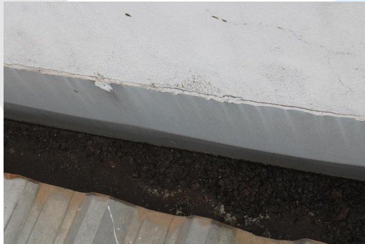
Foto 23 - Atual situação da cobertura 1.
