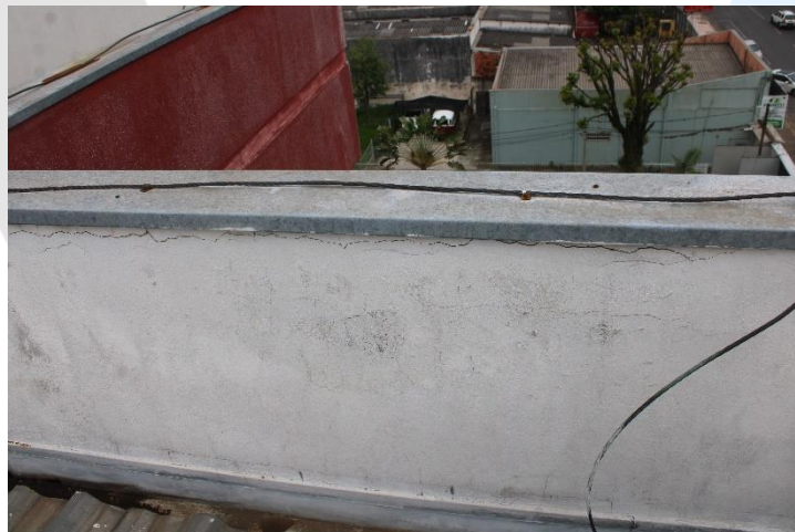
Foto 20 - Atual situação da cobertura 1.
