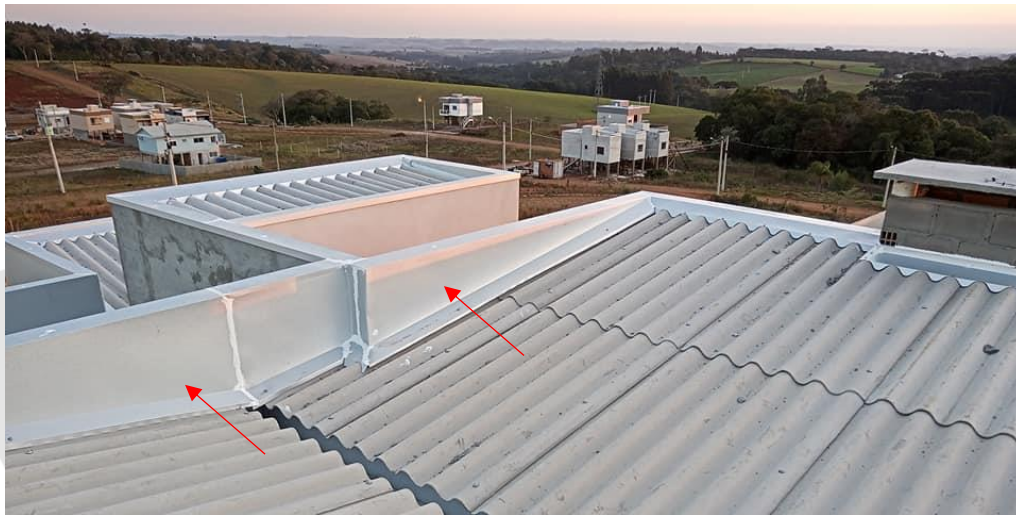
Foto 85- Exemplo de como deve ser executada as capas de platibanda (fonte: Google).
