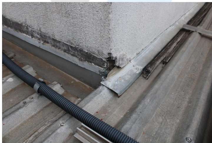
Foto 12 - Atual situação da cobertura 1.
