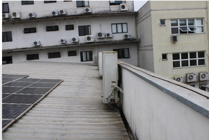
Foto 80 - Atual situação da cobertura 2.
