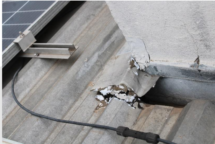
Foto 22 - Atual situação da cobertura 1.
