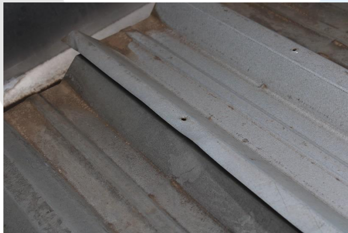
Foto 5- Atual situação da cobertura 1.
