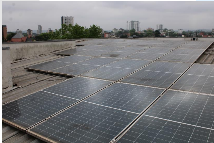
Foto 17 - Atual situação da cobertura 1.
