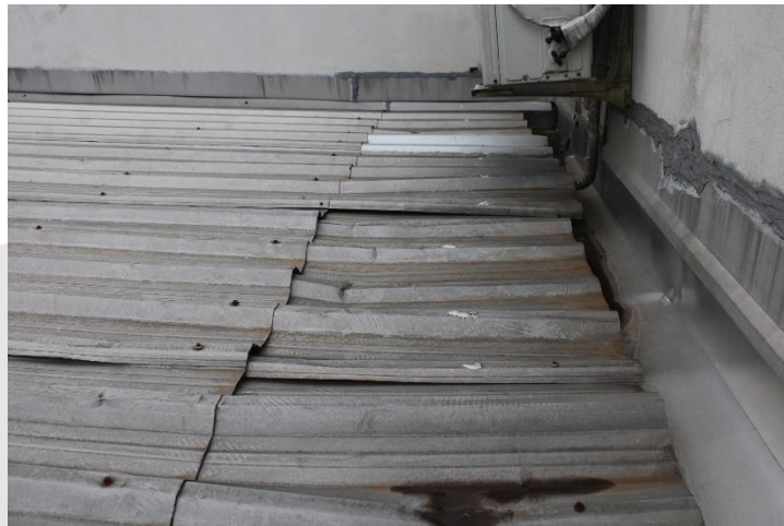
Foto 4- Atual situação da cobertura 1.
