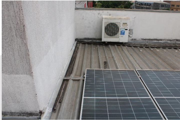
Foto 10 - Atual situação da cobertura 1.
