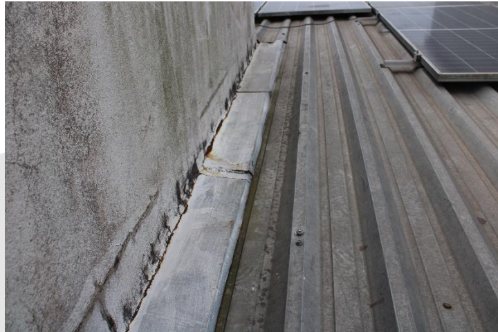
Foto 16 - Atual situação da cobertura 1.
