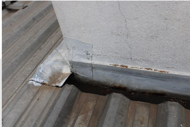
Foto 19 - Atual situação da cobertura 1.
