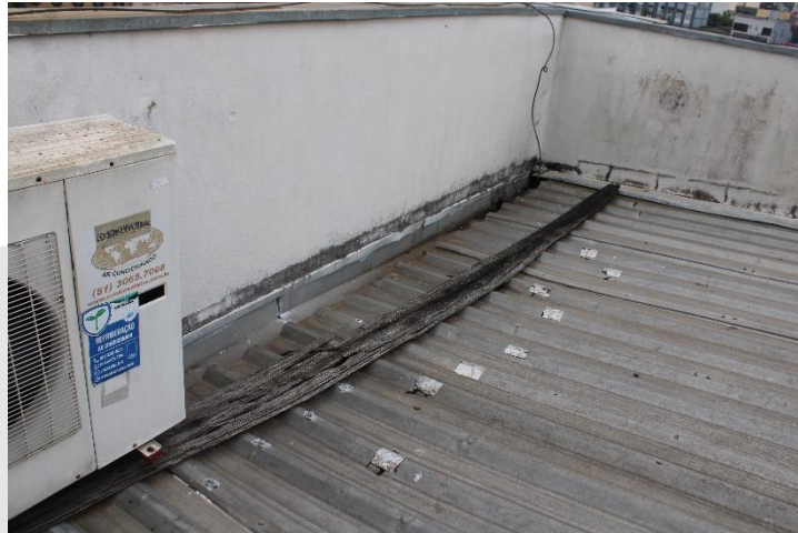
Foto 13 - Atual situação da cobertura 1.
