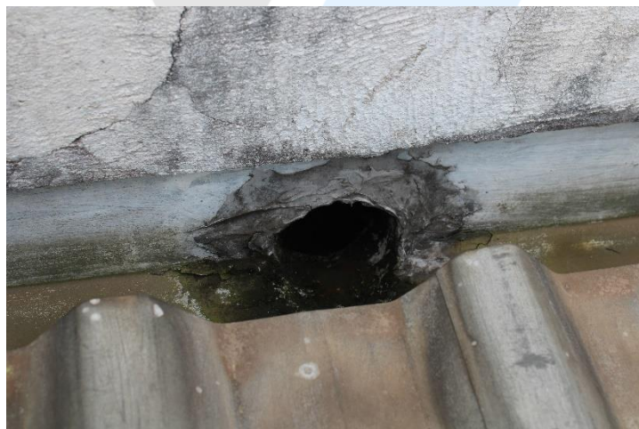
Foto 73 - Atual situação da cobertura 2.
