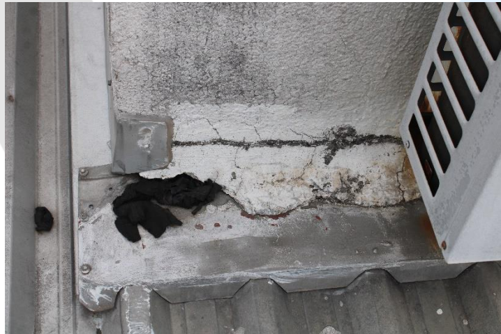
Foto 26 - Atual situação da cobertura 1.
