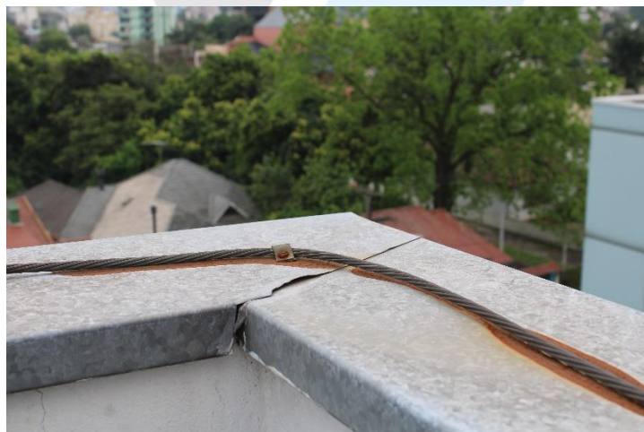
Foto 24 - Atual situação da cobertura 1.
