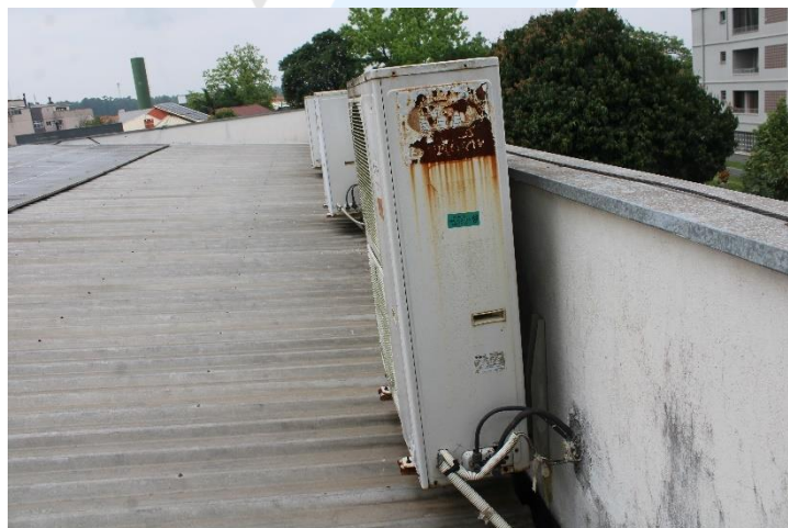
Foto 70 - Atual situação da cobertura 2.
