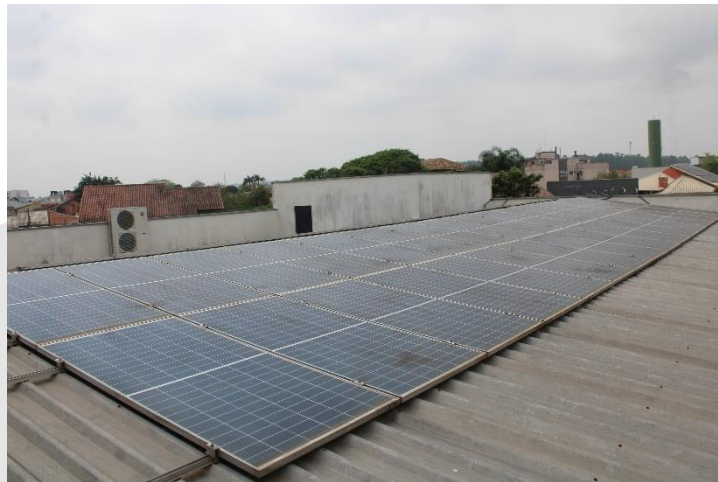
Foto 71 - Atual situação da cobertura 2.
