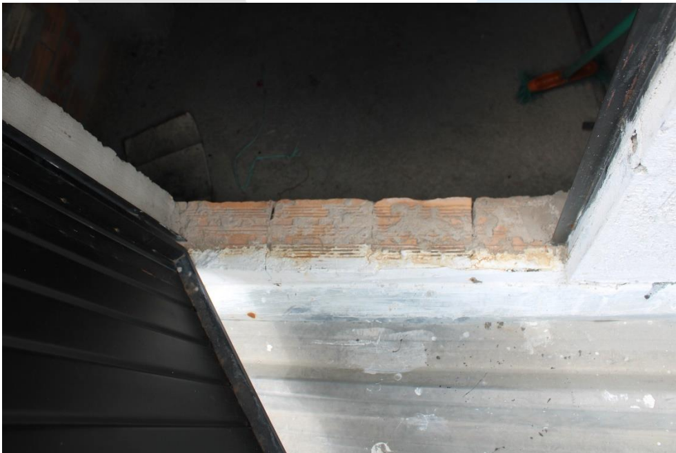
Foto 101- Ausência de peitoril na porta do abrigo do reservatório de água.
