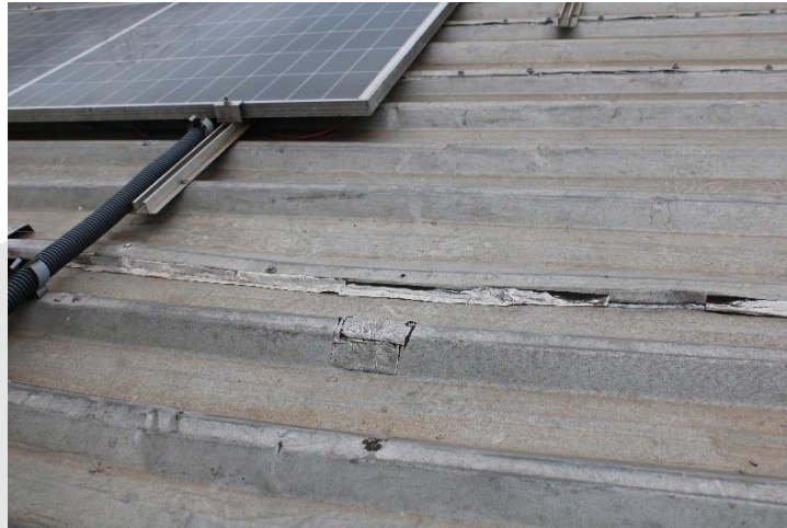
Foto 34- Atual situação da cobertura 1.
