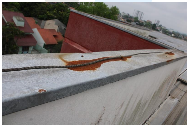
Foto 15 - Atual situação da cobertura 1.
