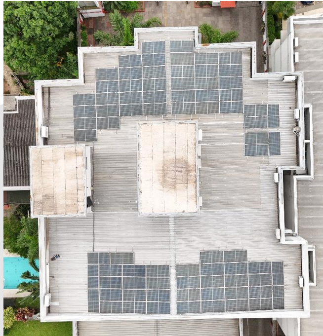
Foto 2- Vista geral da cobertura 1.
