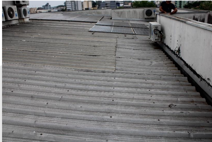
Foto 31 - Atual situação da cobertura 1.
