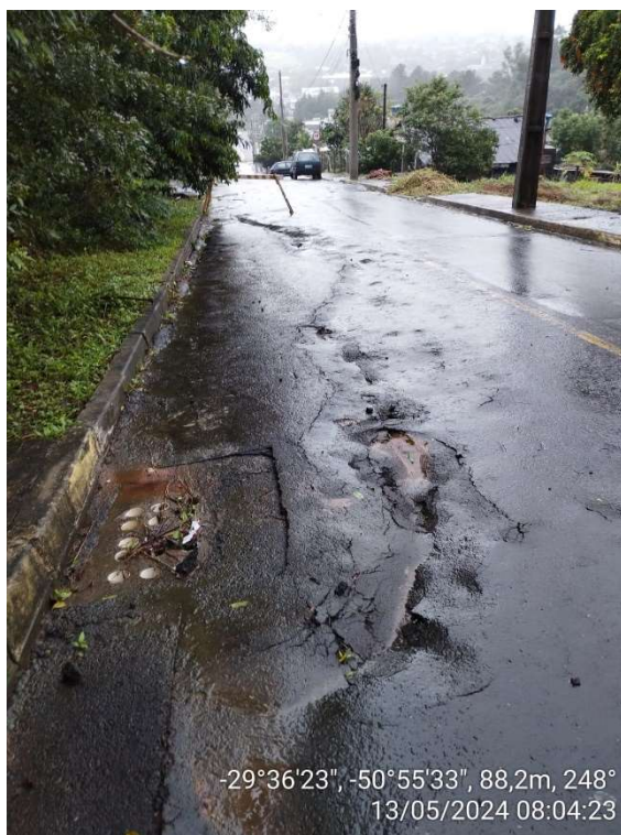
Foto 3: Vista da camada asfáltica e a boca de lobo a ser substituída por grade de ferro. A tubulação de drenagem pluvial está instalada sob o passeio
