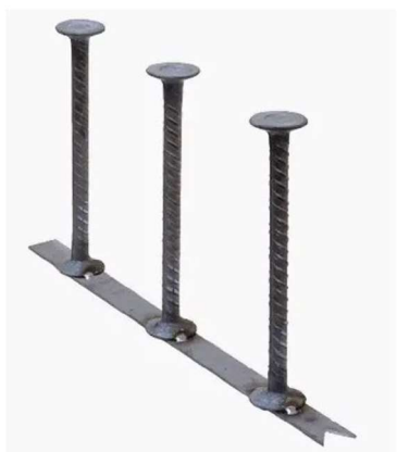
Figura 22 – Exemplo de armadura de punção isolada
