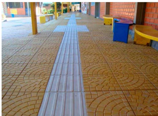
Figura 2: Piso tátil em concreto pré-moldado
