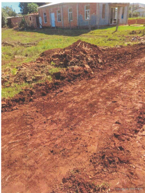
Imagem 11: Local onde será instalada uma das bocas de lobo.
