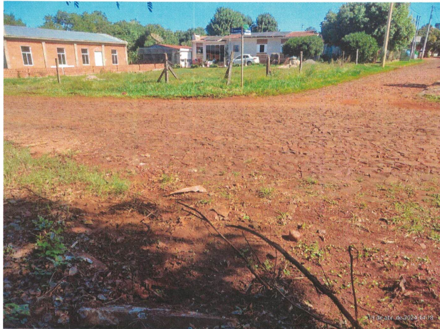
Imagem 15: Local onde será instalada duas bocas de lobo.
