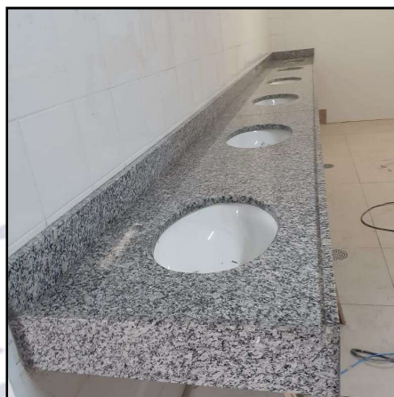
Figura 11 - Imagem exemplificativa da bancada de granito dos sanitários
