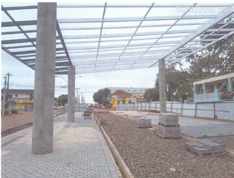
Figura 5: Vista do interior da obra mais ao centro em direção a extremidade sul, nas laterais pavimentação de Intertravado parcialmente executada, sendo necessário acabamento, rejunte e compactação, ao centro canaletas de drenagem, sendo necessário acabamento e instalação de grelha, execução do piso drenante, nota-se ainda depositados blocos de concreto do piso intertravado.
