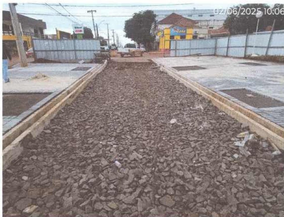
Figura 6: Vista geral da extremidade Sul da obra, nas laterais pavimentação de Intertravado parcialmente executada, ao centro as canaletas de drenagem, sendo necessário acabamento e instalação de grelha, execução do piso drenante, e fechamento do vão de tapume.
