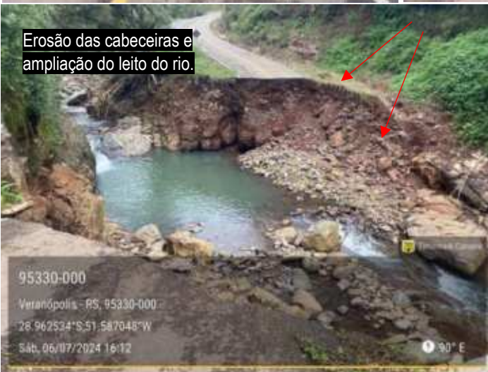
Erosão das cabeceiras e ampliação do leito do rio. No detalhe o tabuleiro levado.
