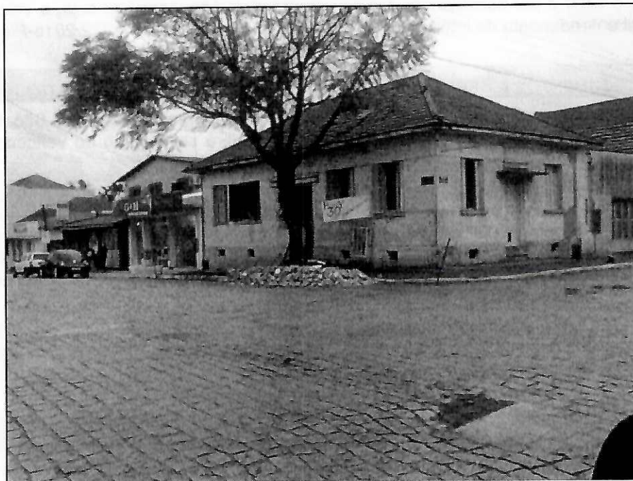
Figura 1 - Imagem da esquina das Ruas Cel. Soares de Carvalho e Barreto Leite, 2013, mostrando acúmulo de resíduos na via pública.
