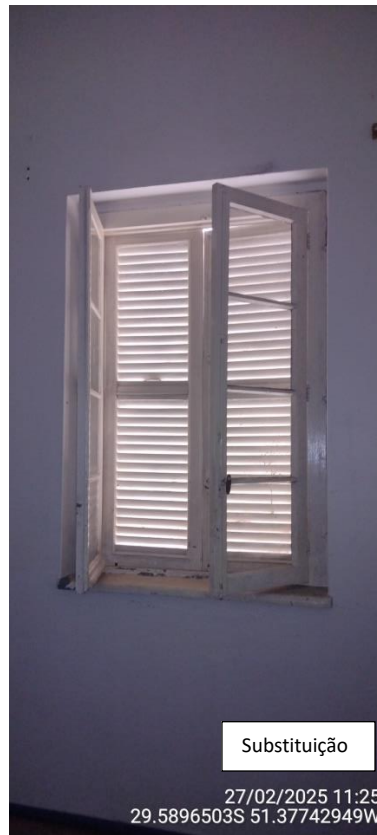
Imagem 28 e 29 – Esquadrias em madeira a serem substituídas.
