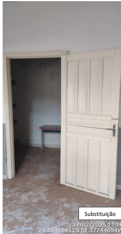
Imagem 60 e 61 – Portas internas a serem substituídas por portas metálicas.
