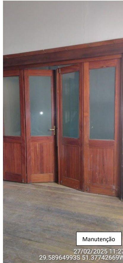
Imagem 45 e 46 – Porta de acesso principal e porta interna em madeira a receberem manutenção e pintura.
