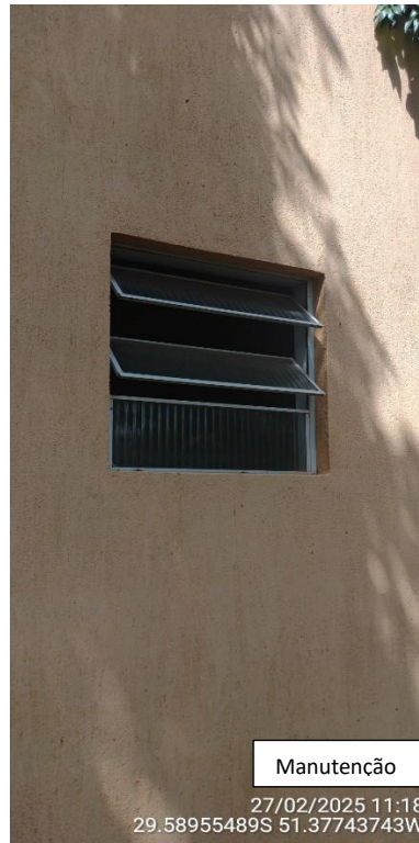
Imagem 39 e 40 – Esquadrias metálicas a receber manutenção e pintura.
