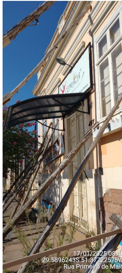
Imagens 16 e 17 – Elétrica e pintura avariadas e escoramento da fachada.
