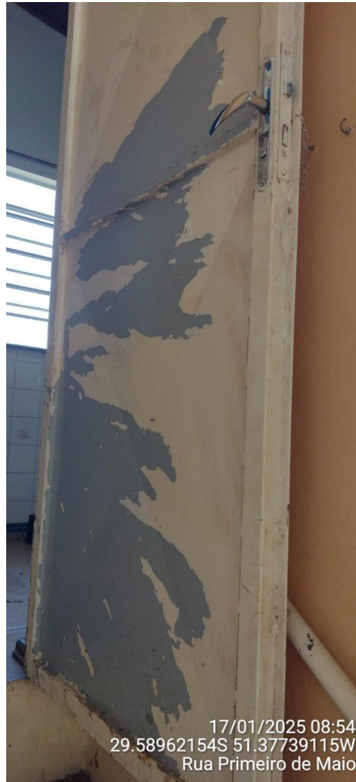
Imagem 74 e 75 – Parede e esquadria a receberem manutenção e pintura .
