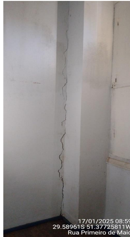
Imagens 12 e 13 – Fissuras verticais na alvenaria.
