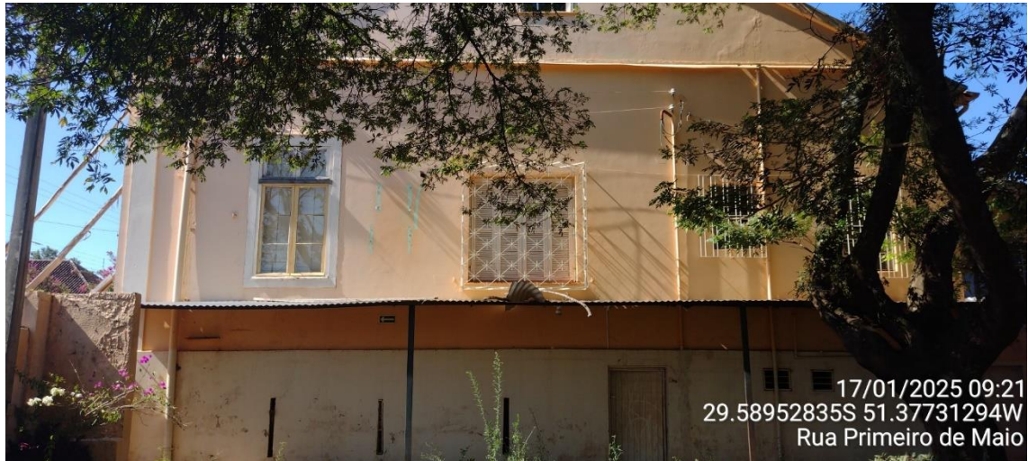
Imagem 03 – Vista lateral direita da edificação principal
