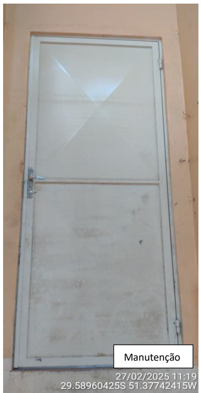
Imagem 56 e 57 – Portas metálicas externas a receberem manutenção e pintura.
