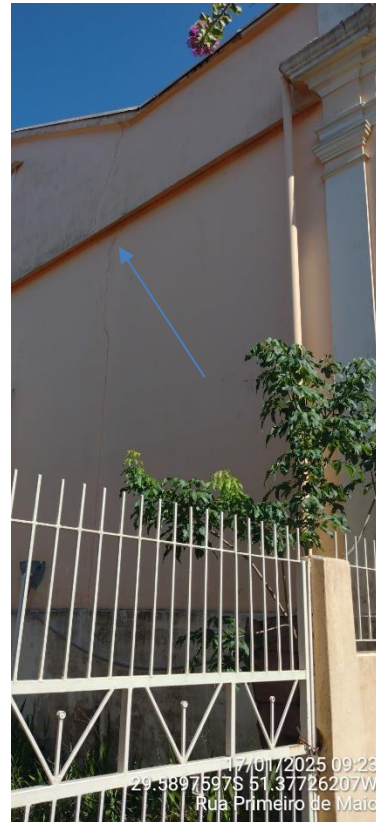
Imagens 05 e 06 – Fachadas laterais com fissura vertical.
