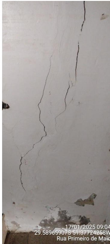
Imagens 08 e 09 – Fissuras verticais na alvenaria.
