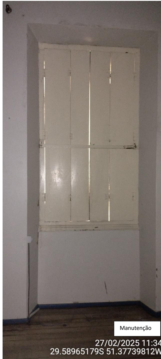
Imagem 36 – Esquadria fachada lateral a receber manutenção e pintura.
