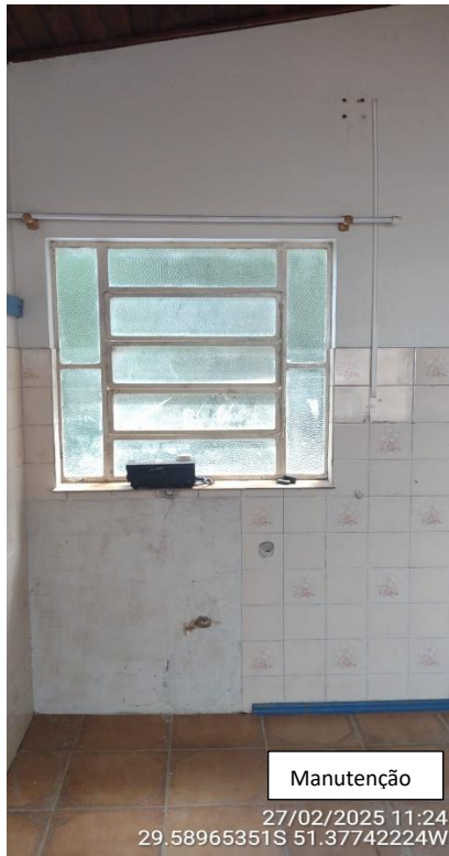
Imagem 39 e 40 – Esquadrias metálicas a receber manutenção e pintura.
