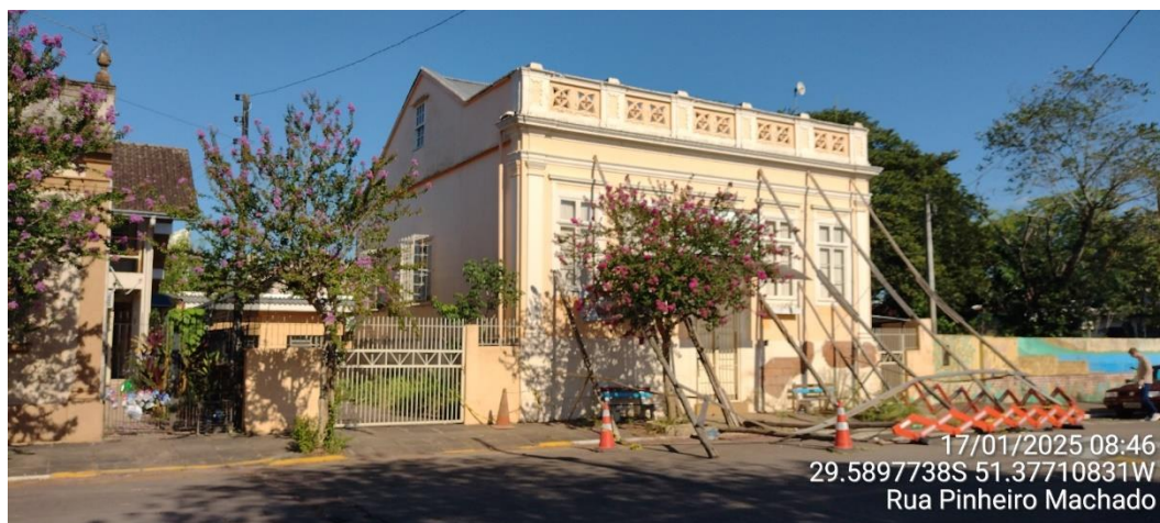
Imagem 02 – Vista lateral esquerda da edificação principal
