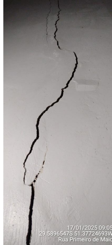
Imagens 08 e 09 – Fissuras verticais na alvenaria.
