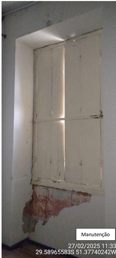
Imagem 32 e 33 – Esquadrias fachada Frontal a receberem manutenção e pintura.
