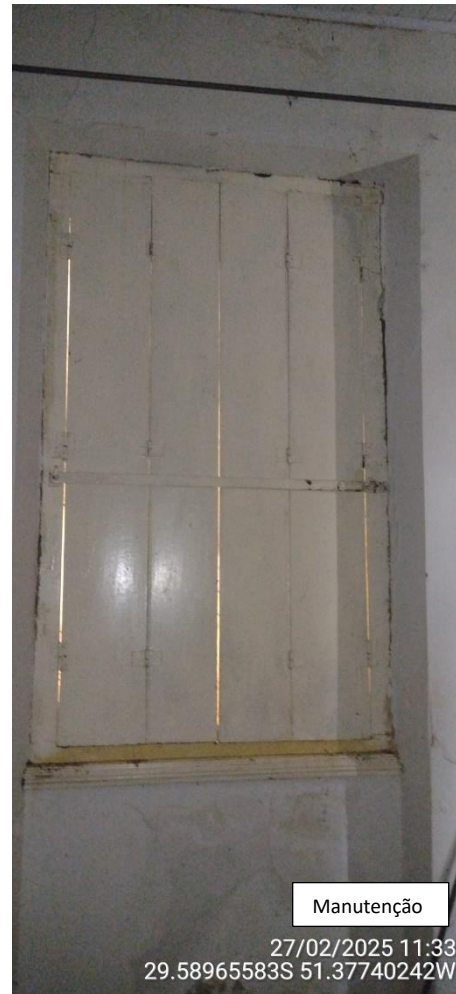
Imagem 32 e 33 – Esquadrias fachada Frontal a receberem manutenção e pintura.
