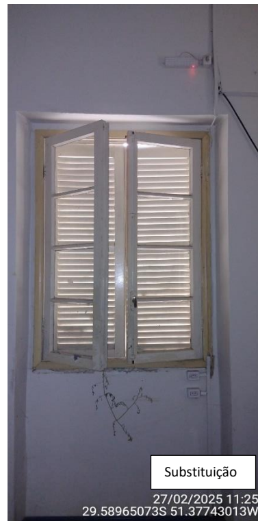
Imagem 30 e 31 – Esquadrias em madeira a serem substituídas.
