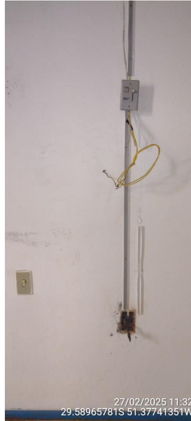
Imagens 20 e 21 – Instalações elétricas afetadas.
