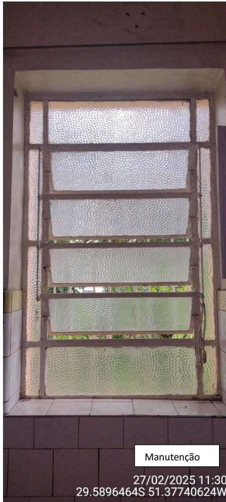
Imagem 26 e 27 – Esquadrias metálicas a receber manutenção e pintura.
