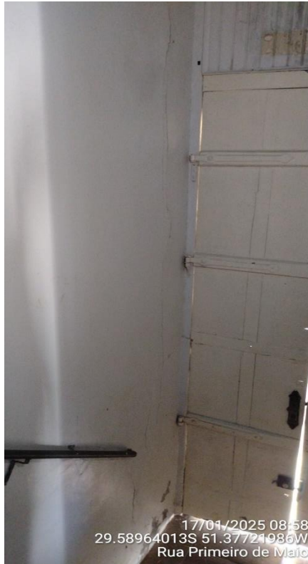
Imagens 12 e 13 – Fissuras verticais na alvenaria.
