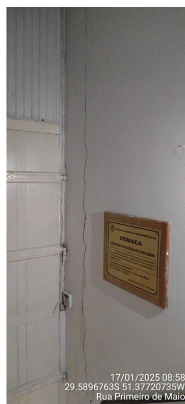
Imagens 10 e 11 – Fissuras verticais na alvenaria.
