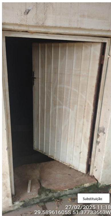
Imagem 63 e 64 – Porta externa metálica a ser substituída / Portão de acesso a receber manutenção e pintura
