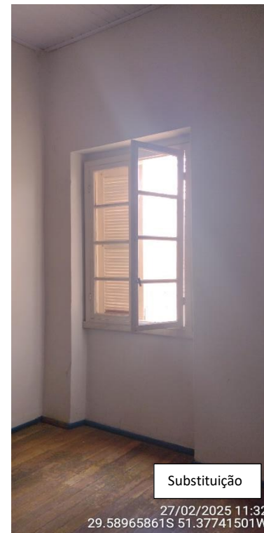
Imagem 30 e 31 – Esquadrias em madeira a serem substituídas.
