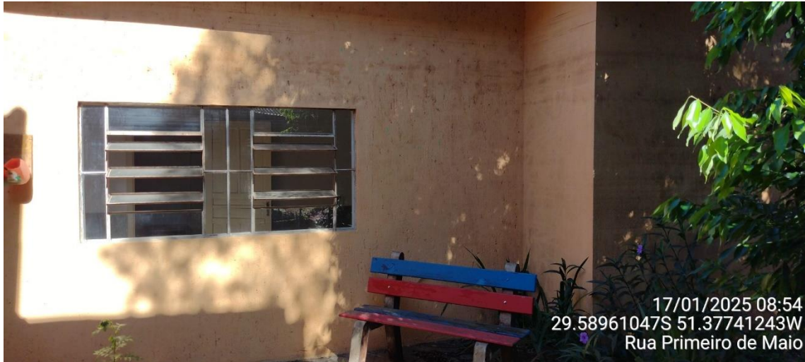
Imagem 69 – Paredes externas prédio fundos.
