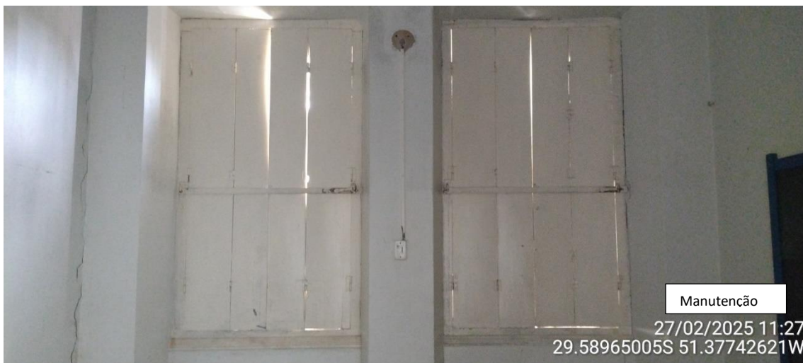
Imagem 34 e 35 – Esquadrias fachada Frontal a receberem manutenção e pintura.
