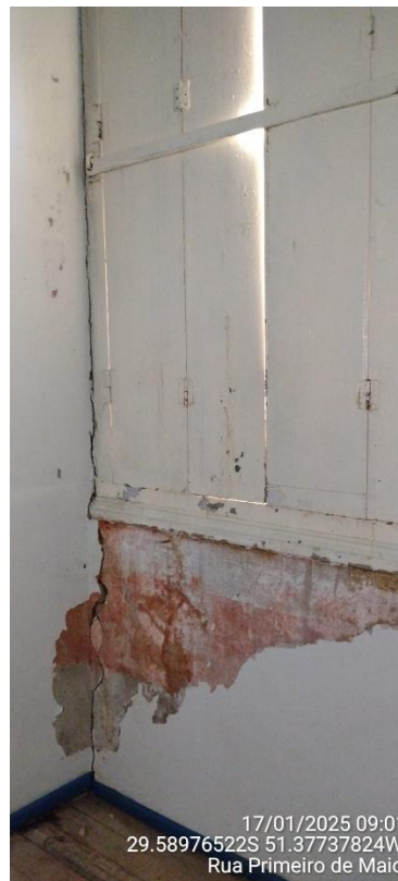
Imagens 10 e 11 – Fissuras verticais na alvenaria.
