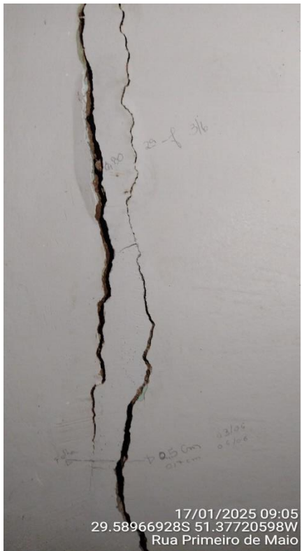
Imagens 14 e 15 – Fissuras verticais na alvenaria.
