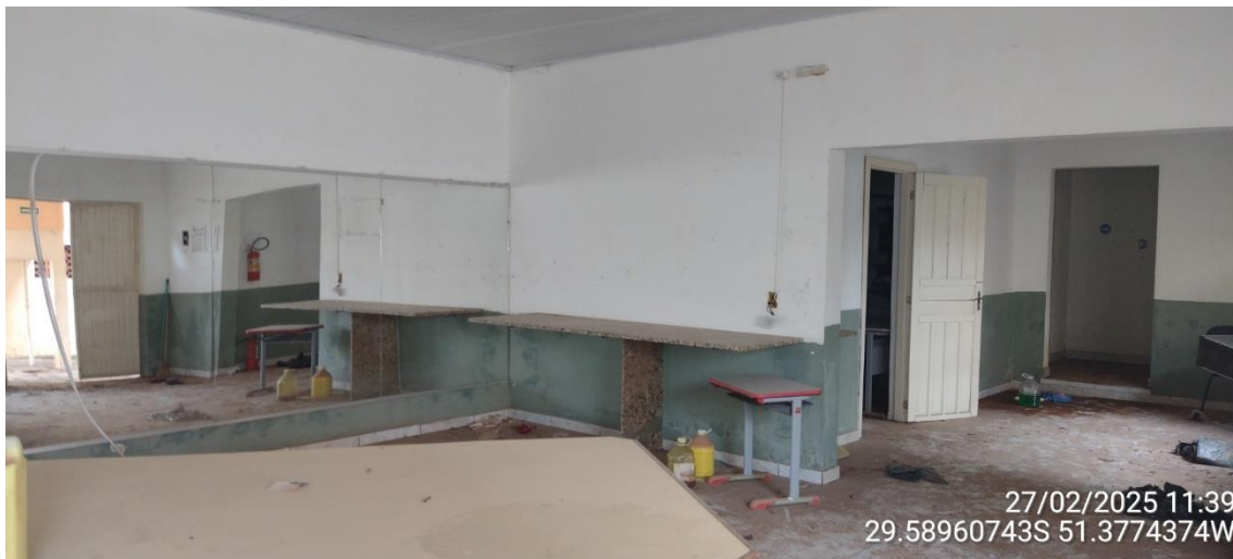
Imagem 65 – Paredes internas a serem pintadas.
