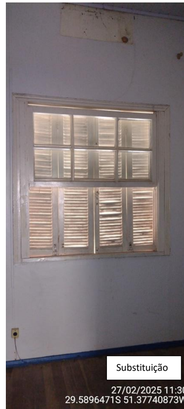
Imagem 28 e 29 – Esquadrias em madeira a serem substituídas.
