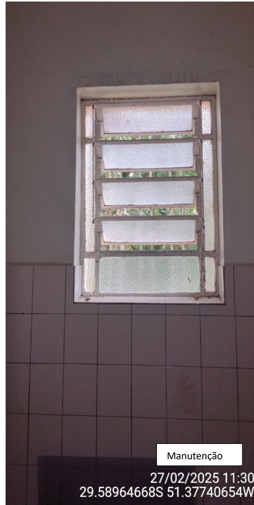
Imagem 26 e 27 – Esquadrias metálicas a receber manutenção e pintura.
