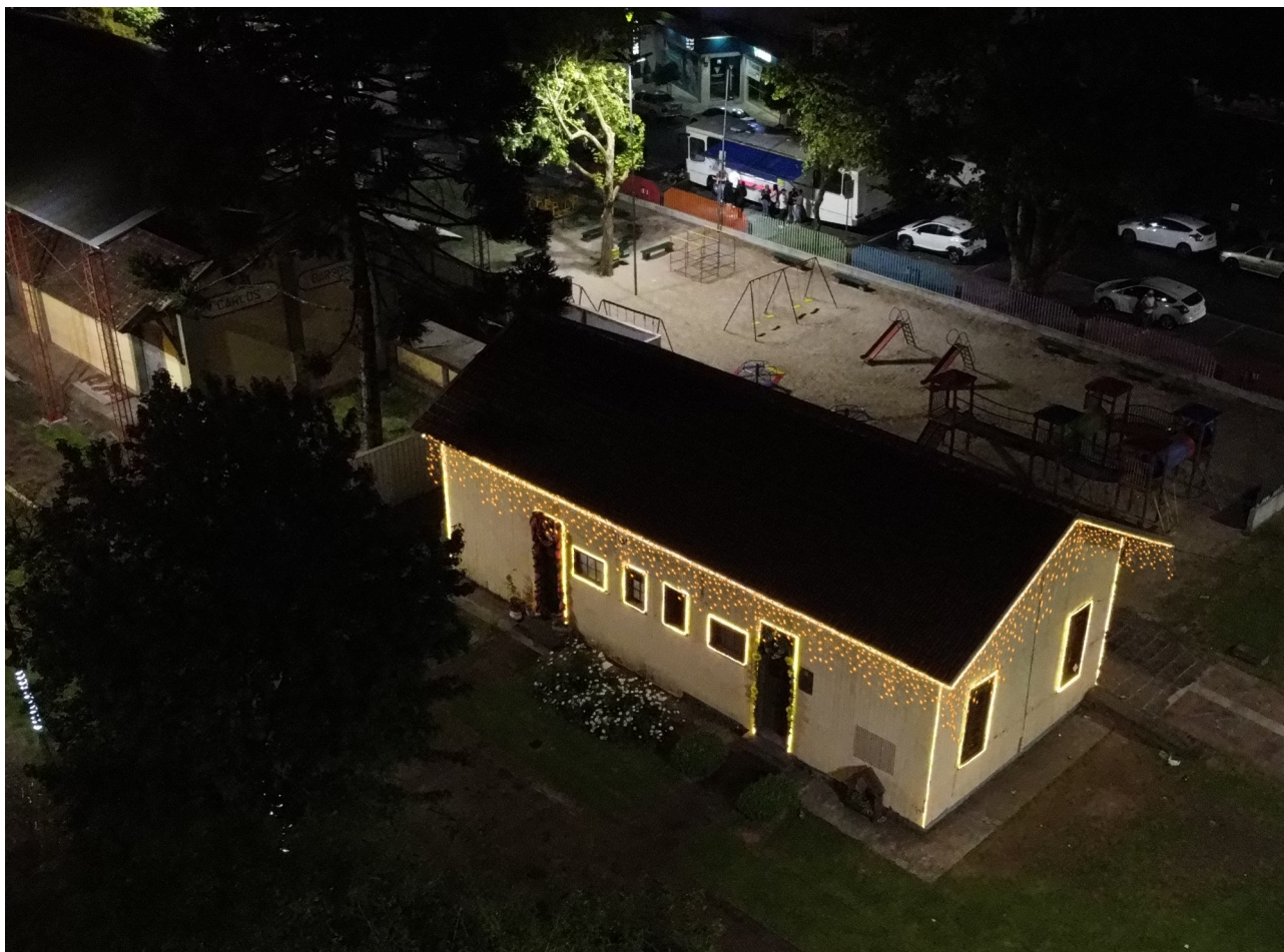
Imagem aérea da Casa do Artesão
