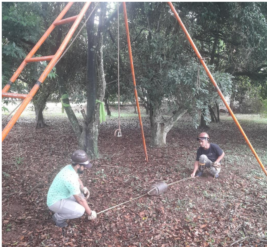
Instalação do furo SP-06 A
