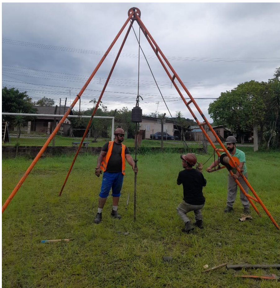
Instalação do furo SP-03
