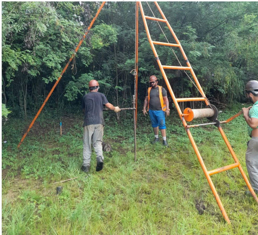
Instalação do furo SP-02
