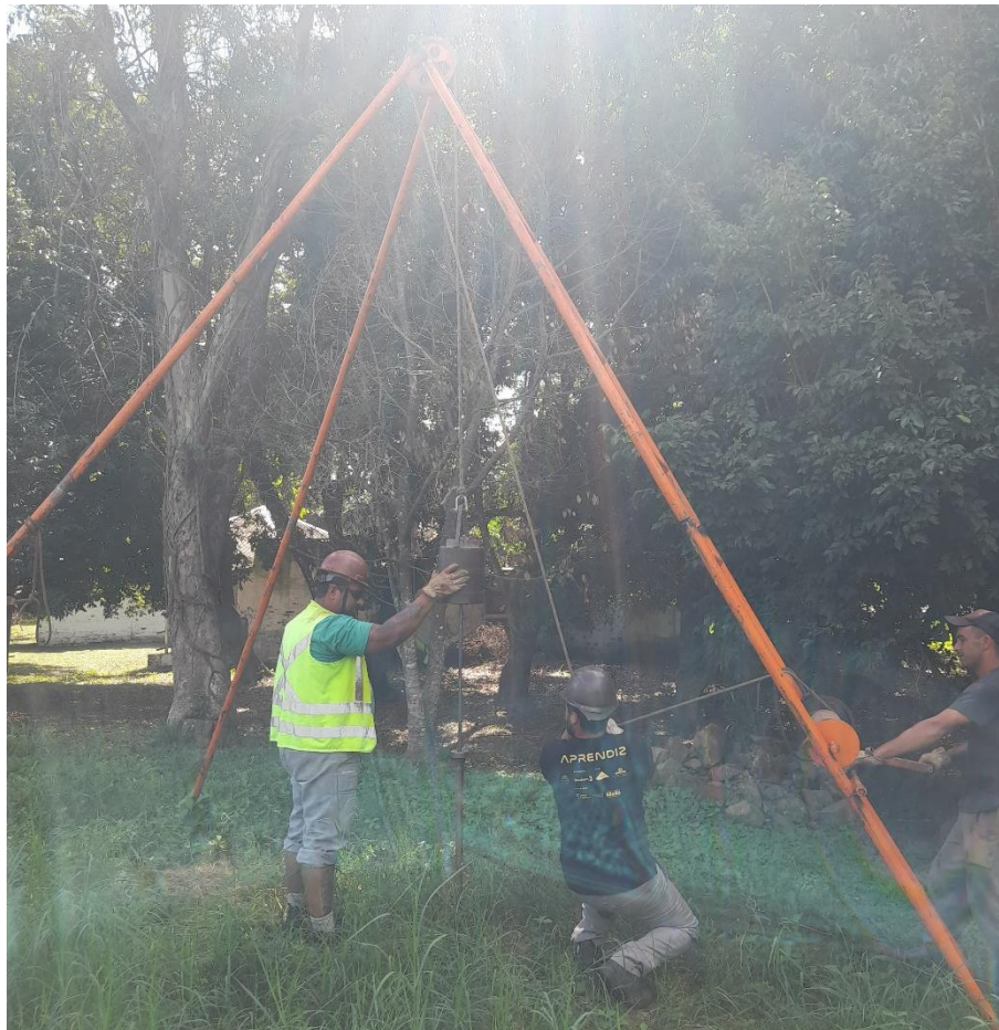
Instalação do furo SP-08
