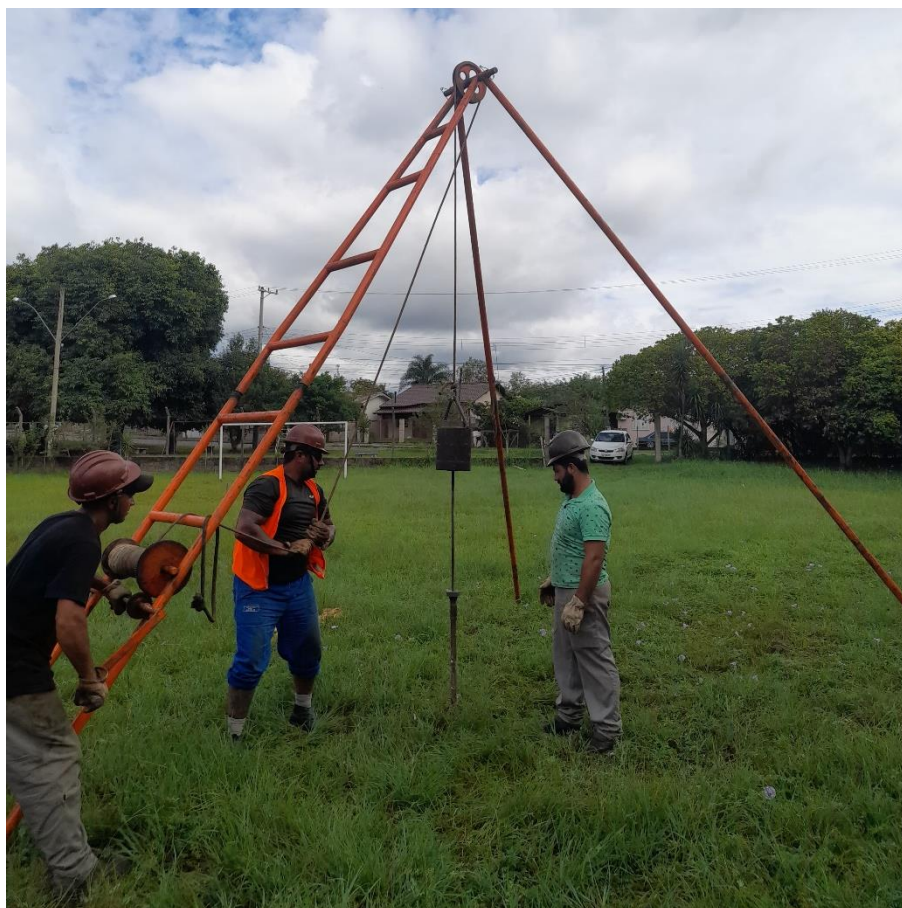
Instalação do furo SP-04
