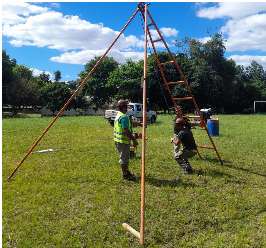
Instalação do furo SP-09
