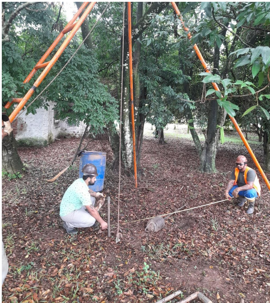
Instalação do furo SP-06 B
