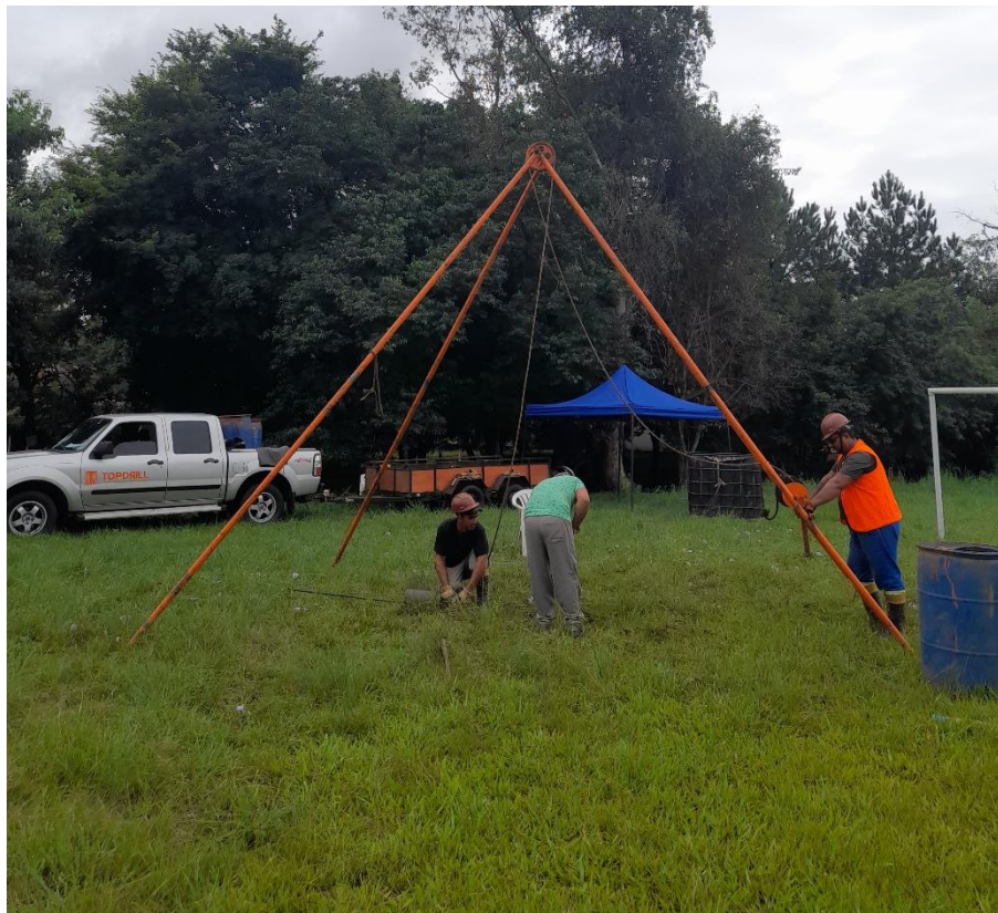
Instalação do furo SP-05
