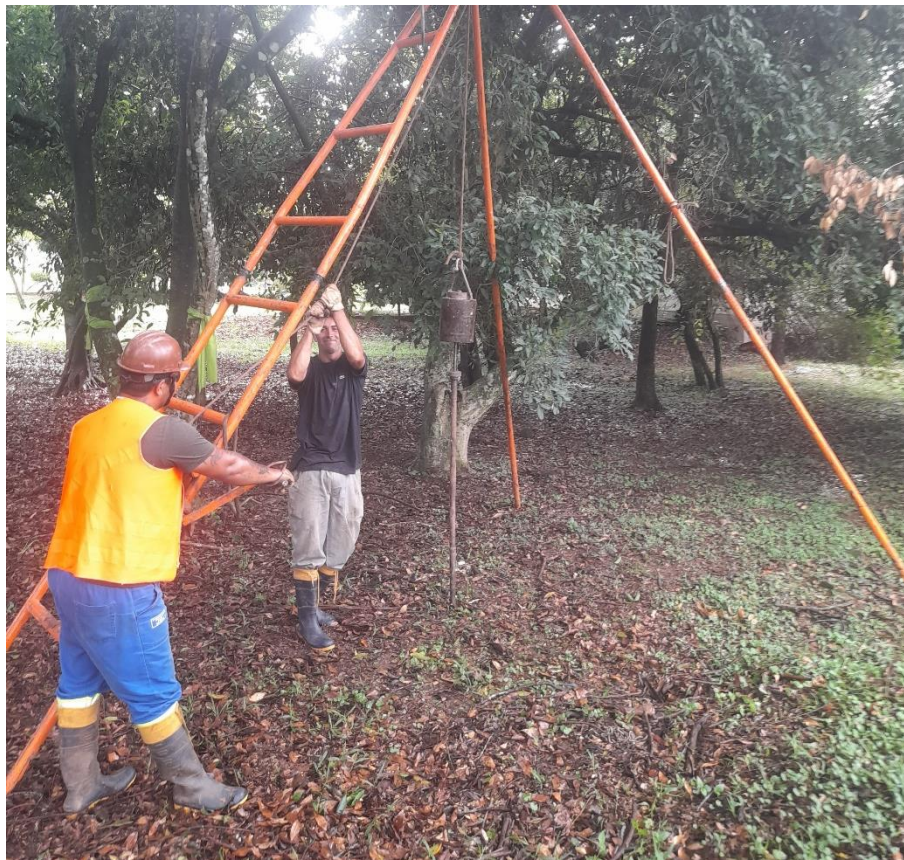
Instalação do furo SP-06
