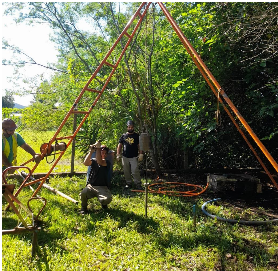
Instalação do furo SP-01
