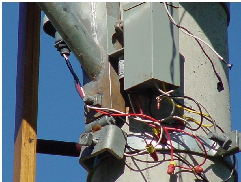
Articulador sendo instalado
