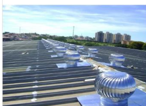
Exaustor Eólico Completo 24 Polegadas Instalação em telhado
