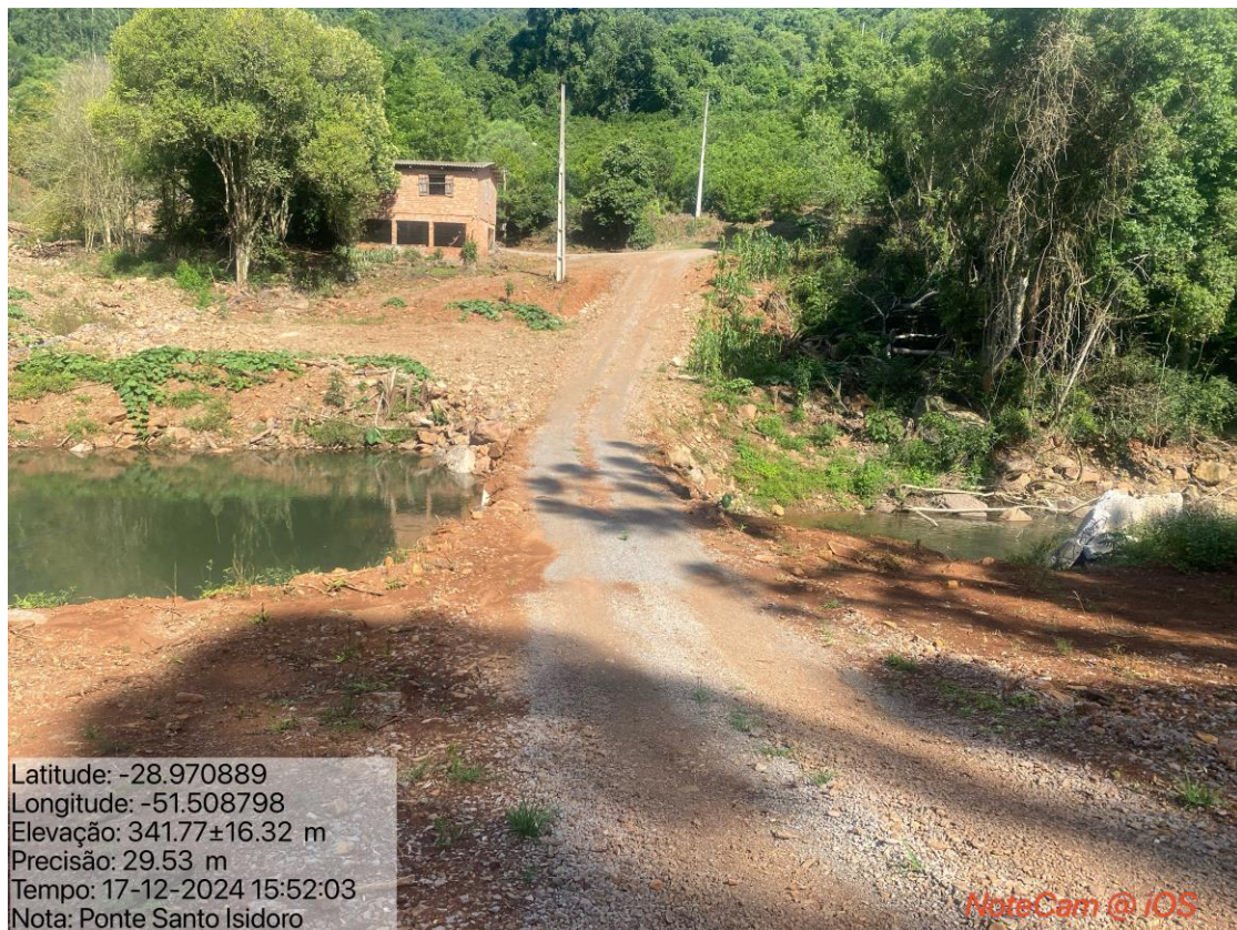
Imagem 6: imagem geral do local onde havia a ponte que foi destruída durante o evento climático.
