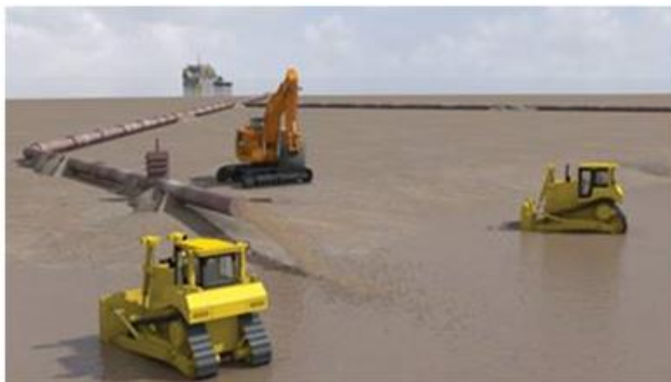
Figure 35 - Desenho esquemático os equipamentos acessórios para mover e moldar os sedimentos durante o descarte em terra.
