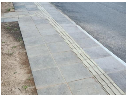
Figura 6: Referência de execução de piso em pedra de basalto
