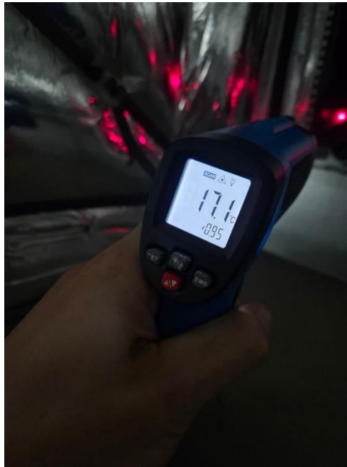
Temperatura de Insuflamento EQ 03 354
