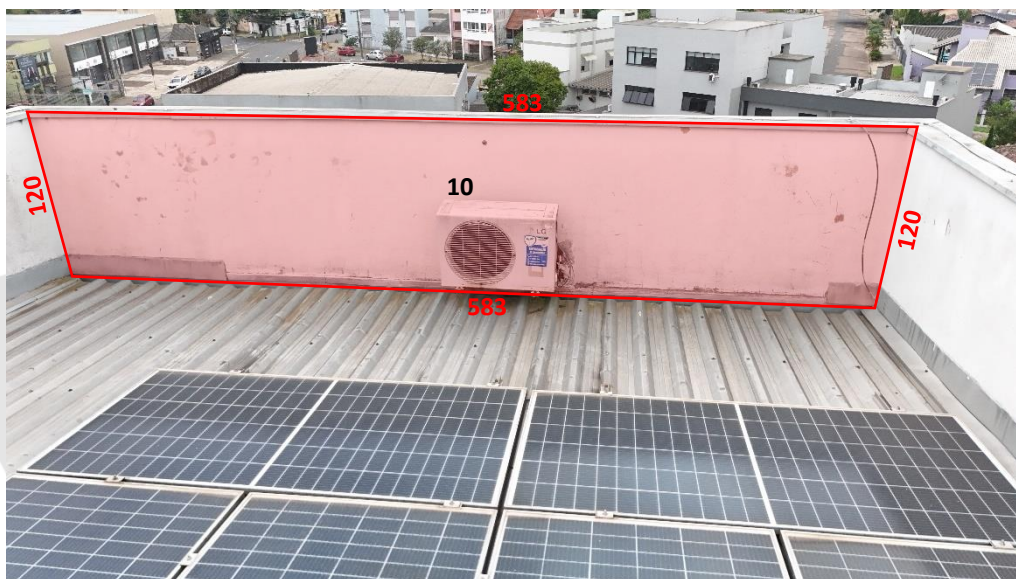
Foto 46 – Medidas da platibanda 10 em cm.
