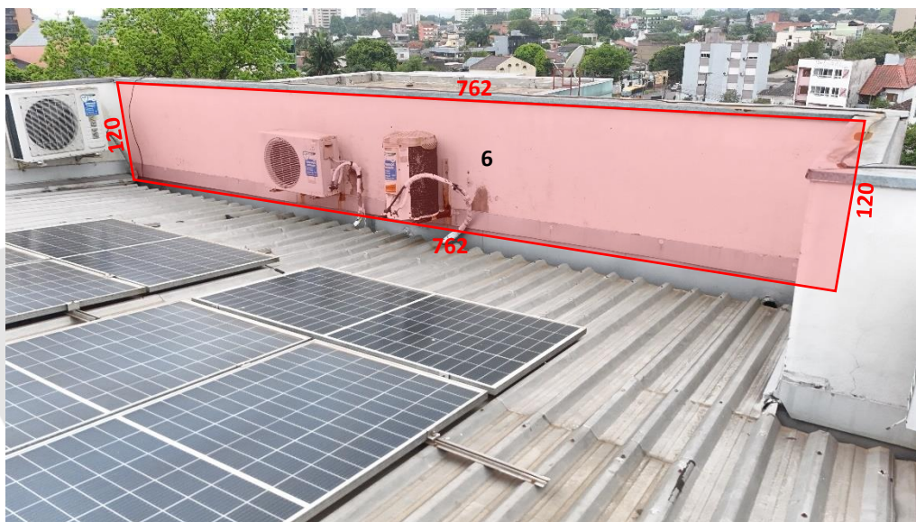
Foto 42 – Medidas da platibanda 6 em cm.
