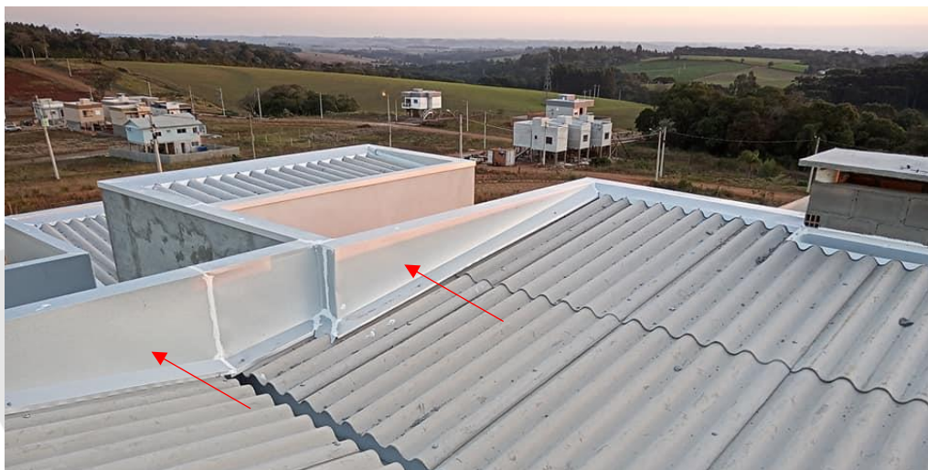
Foto 35 – Exemplo de como deve ser executada as capas de platibanda (fonte: Google).
