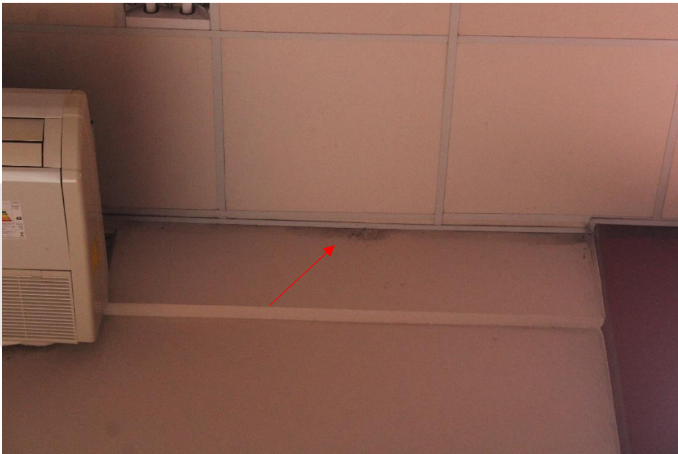
Foto 66- Sinais de infiltração nas paredes do auditório.
