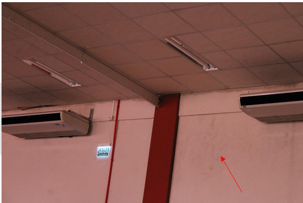
Foto 64- Sinais de infiltração nas paredes do auditório.
