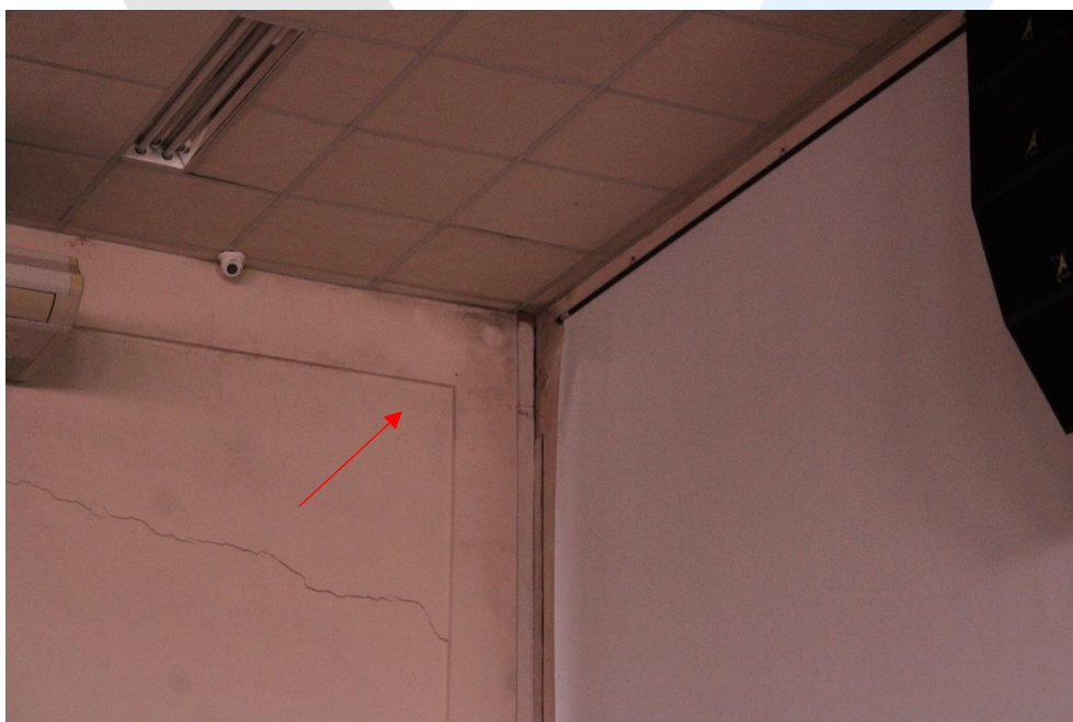
Foto 65- Sinais de infiltração nas paredes do auditório.
