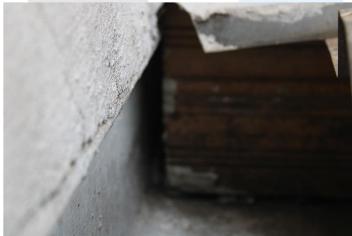
Foto 93- Presença de tijolos na calha.
