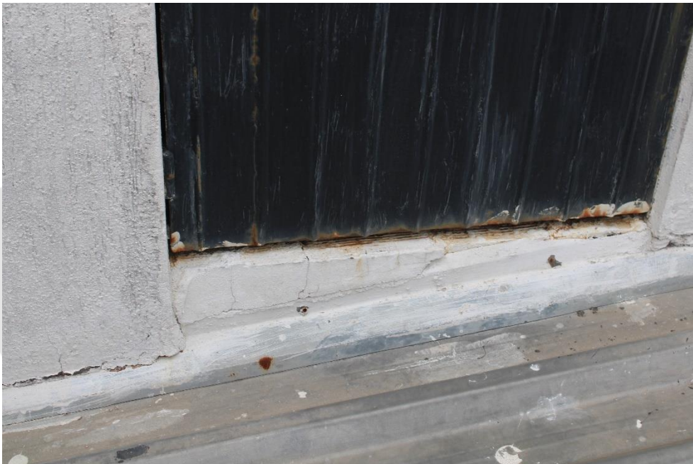
Foto 100- Ausência de peitoril na porta do abrigo do reservatório de água.
