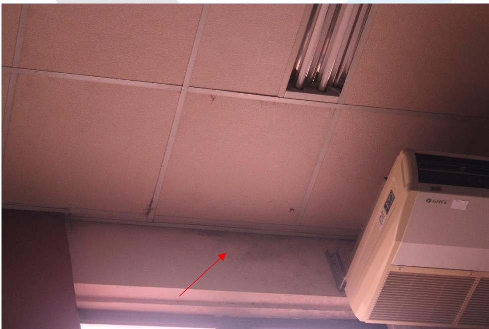
Foto 67- Sinais de infiltração nas paredes do auditório.
