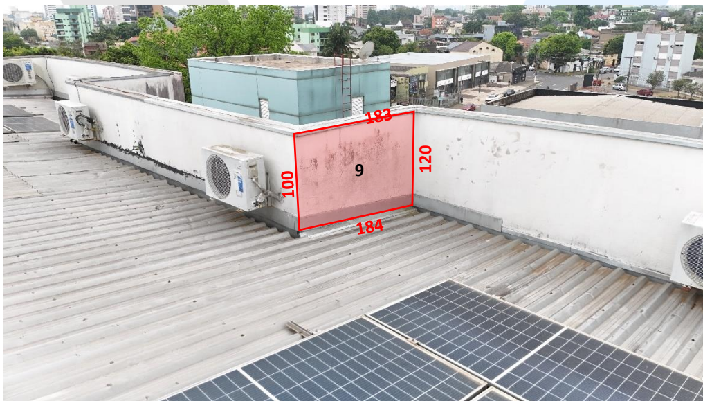
Foto 45 – Medidas da platibanda 9 em cm.
