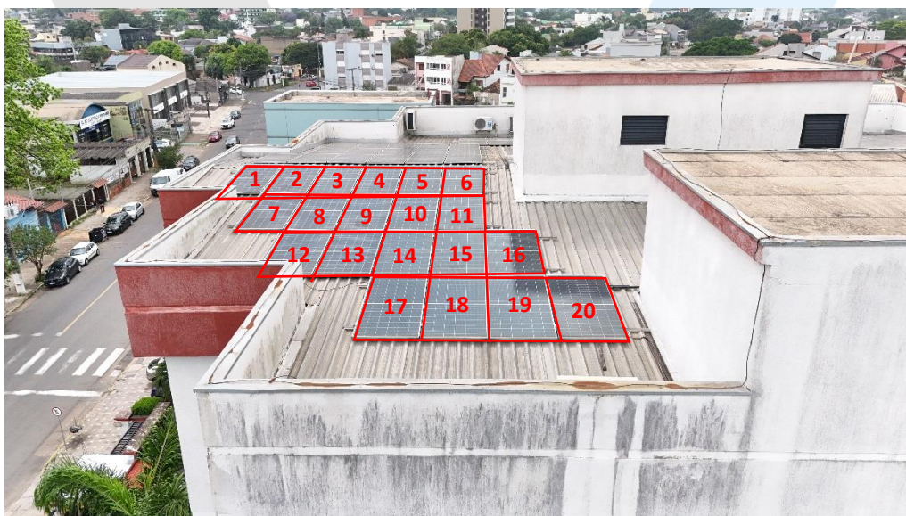
Foto 59 - Placas fotovoltaicas da cobertura 1.
