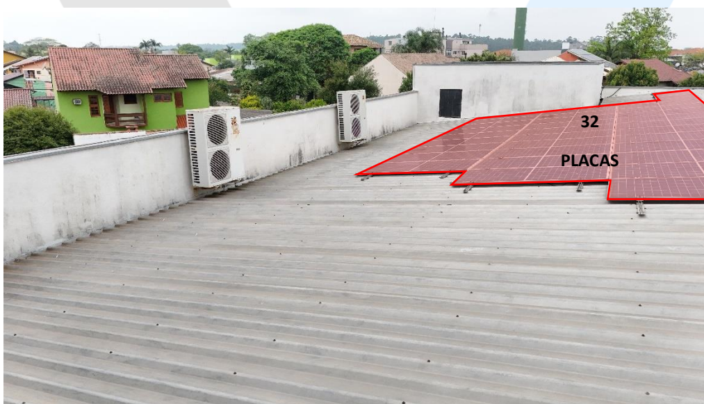
Foto 98 – Placas fotovoltaicas da cobertura 2.
