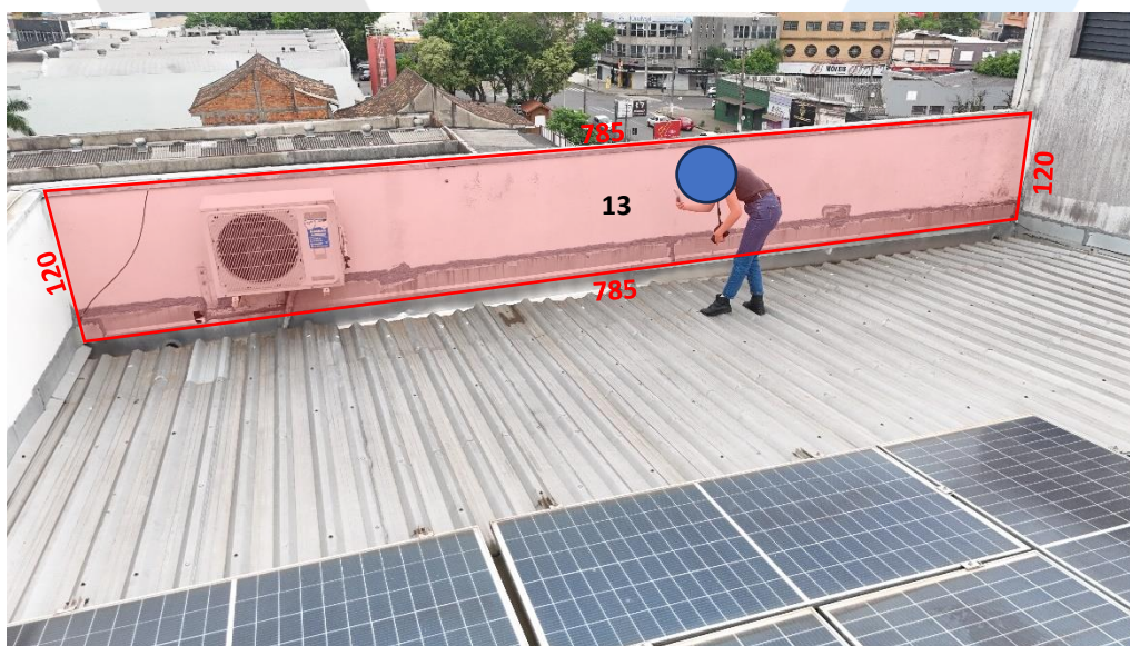
Foto 49 – Medidas da platibanda 13 em cm.
