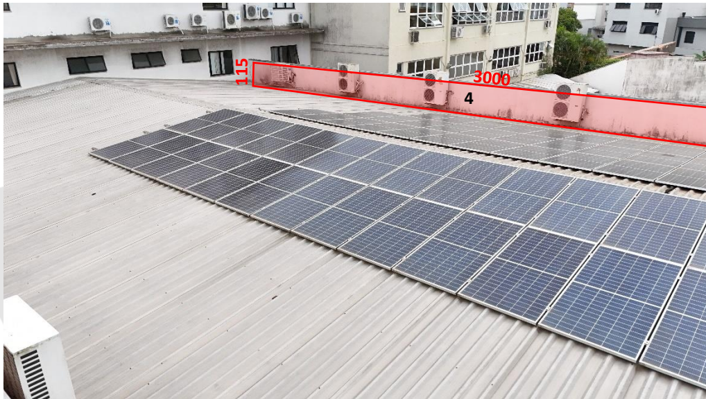
Foto 90 – Medidas da platibanda 4.
