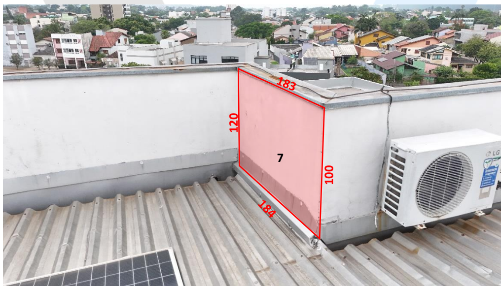
Foto 43 – Medidas da platibanda 7 em cm.
