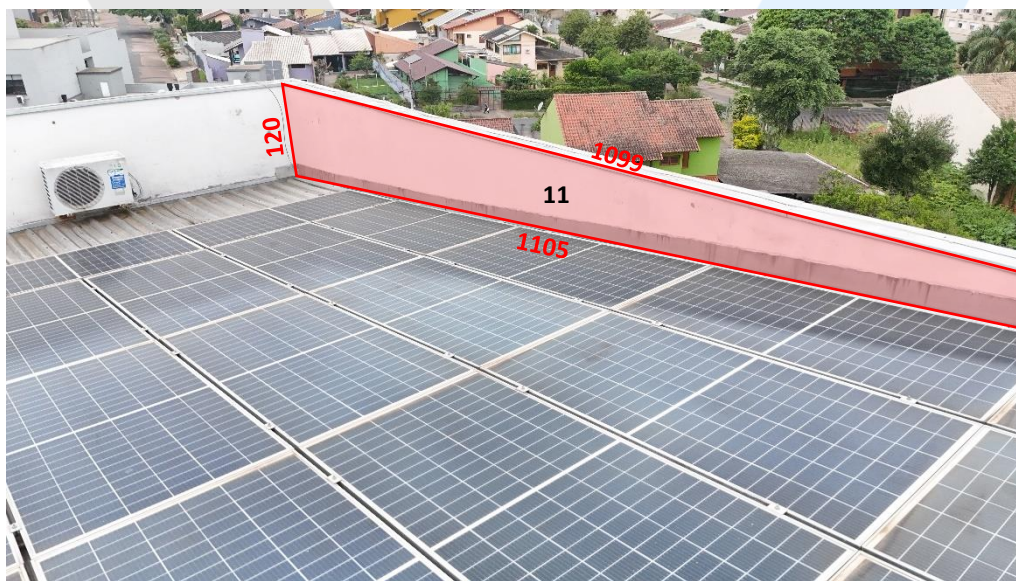
Foto 47 – Medidas da platibanda 11 em cm.
