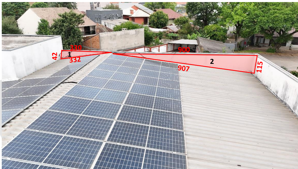
Foto 88 – Medidas das platibandas 1 e 2.
