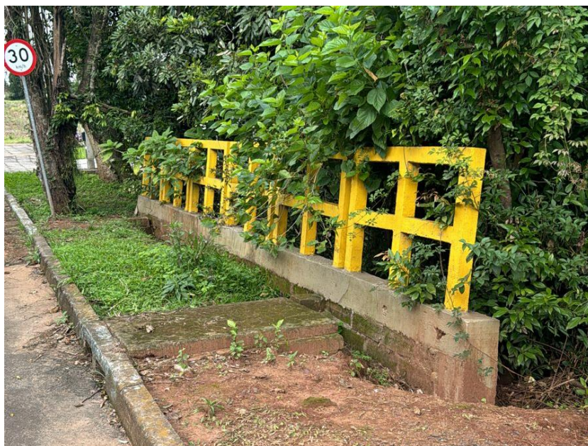
Figura 4: Guarda – corpo a ser recuperado
