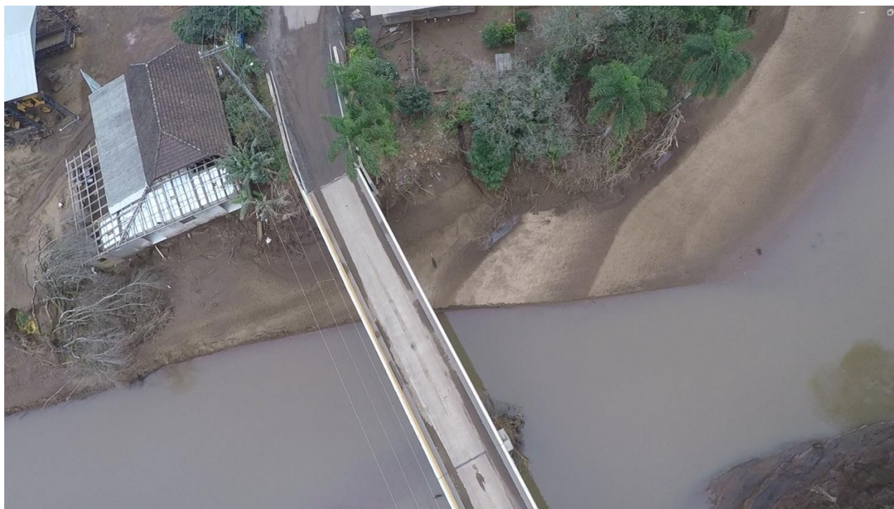
Figura 2: Imagem recente do local a ser executada a contenção com gabiões após enchente de Maio/2024 – Imagem de drone
