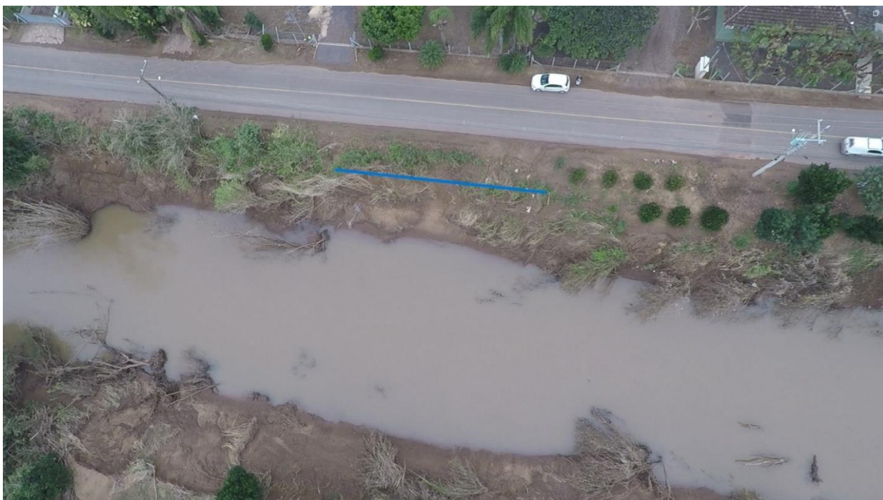
Figura 2: Imagem recente do local a ser executado o enrocamento após enchente de Maio/2024 – Imagem de drone
