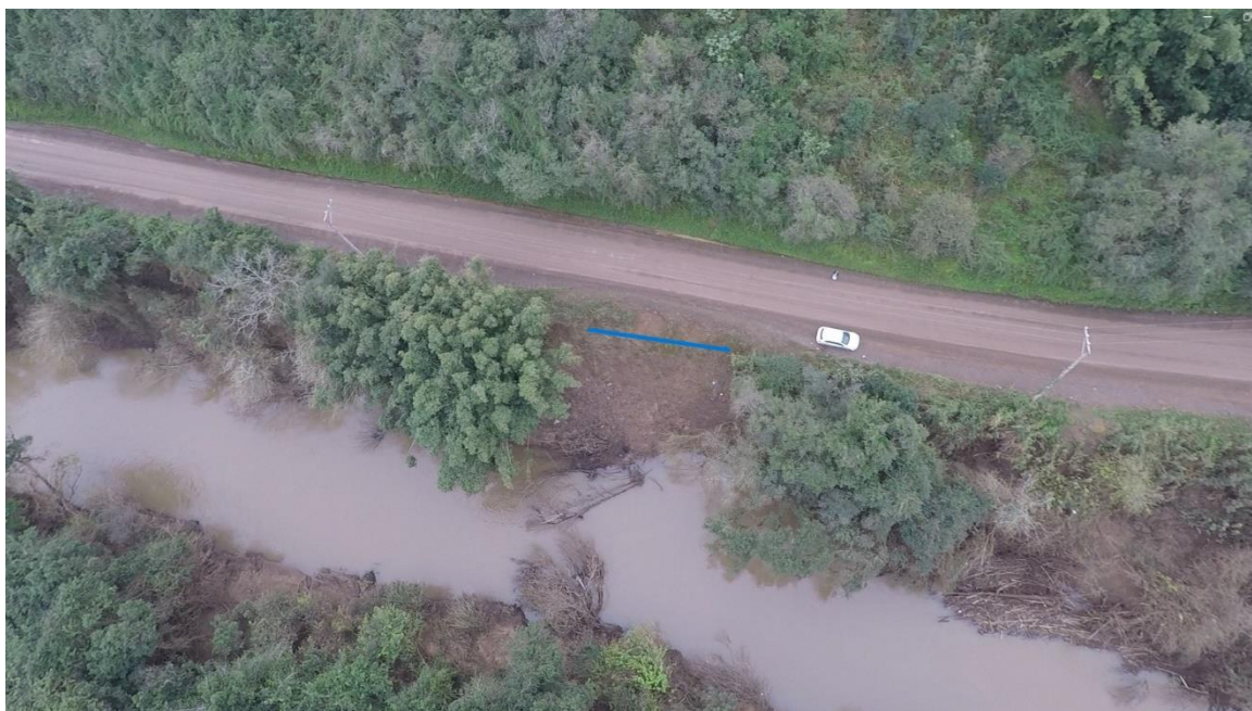
Figura 4: Imagem recente do local a ser executado o enrocamento após enchente de Maio/2024 – Imagem de drone
