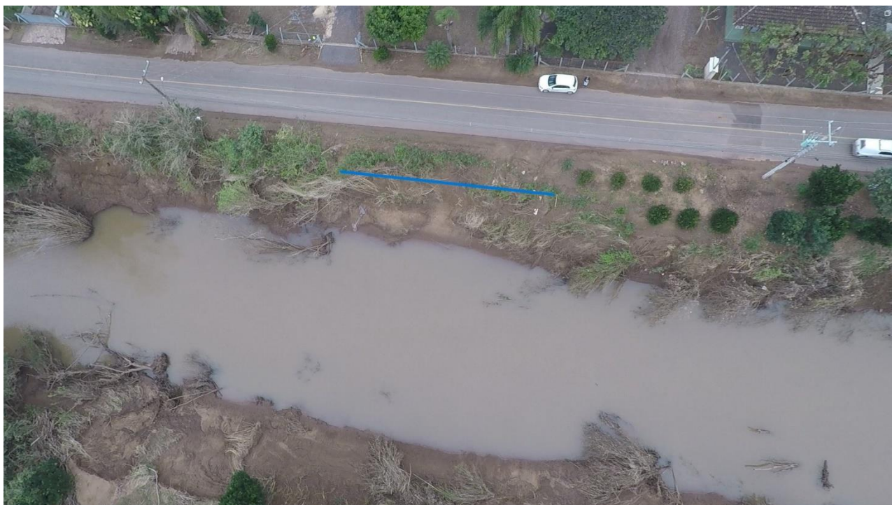
Figura 3: Imagem recente do local a ser executado o enrocamento após enchente de Maio/2024 – Imagem de drone
