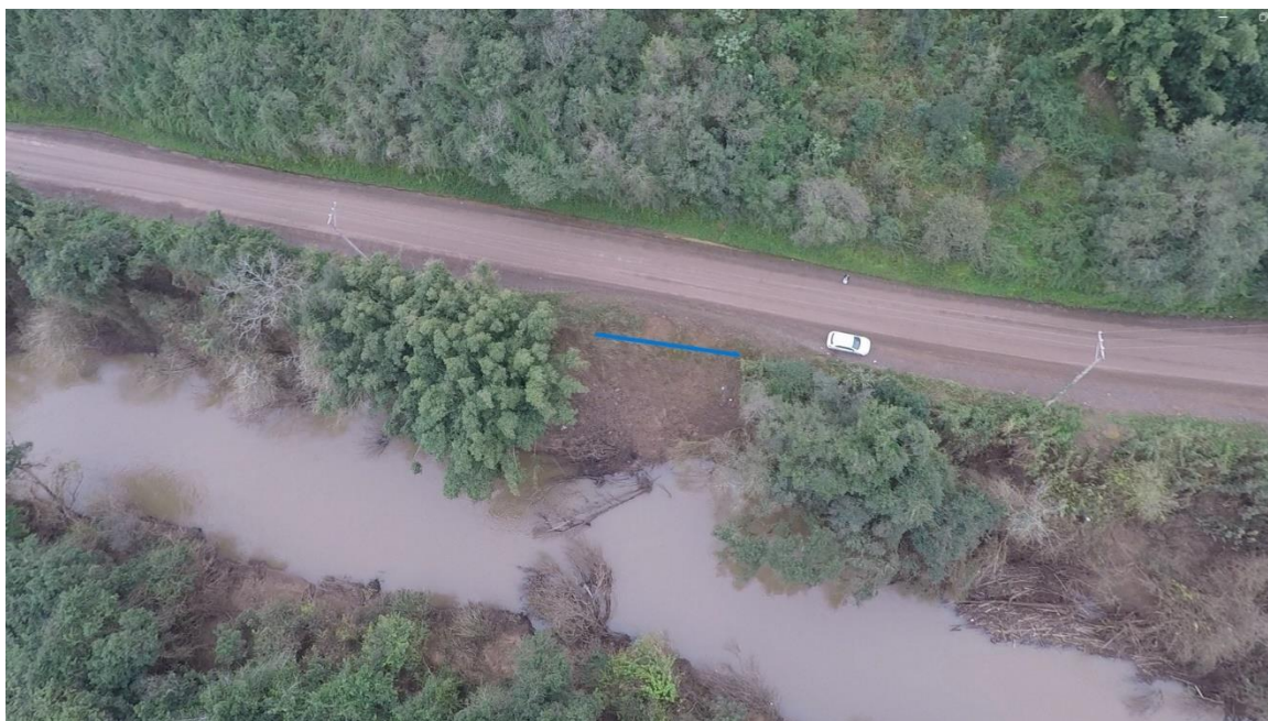
Figura 5: Imagem recente do local a ser executado o enrocamento após enchente de Maio/2024 – Imagem de drone
