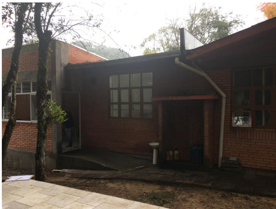
Figura 1 - Vista externa da cozinha (no centro), com refeitório à esquerda e depósito à direita.
