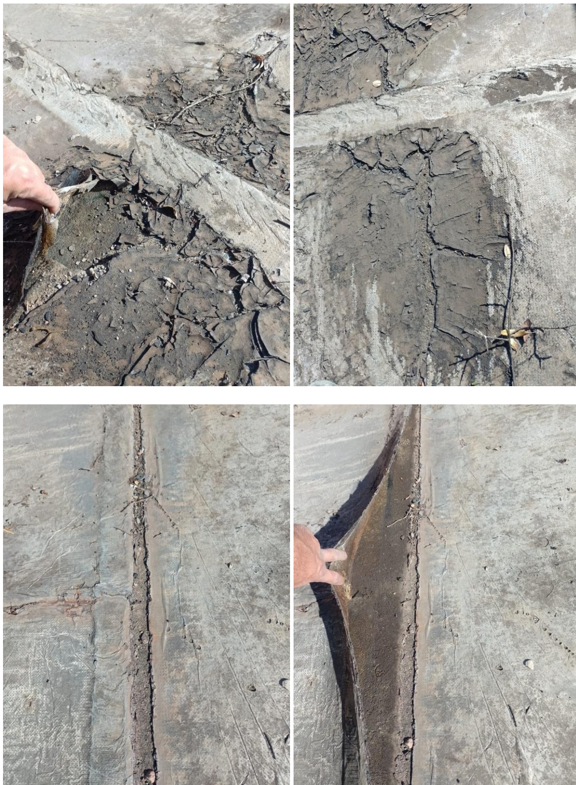
Figura 5 - Impermeabilização da laje deteriorada.
