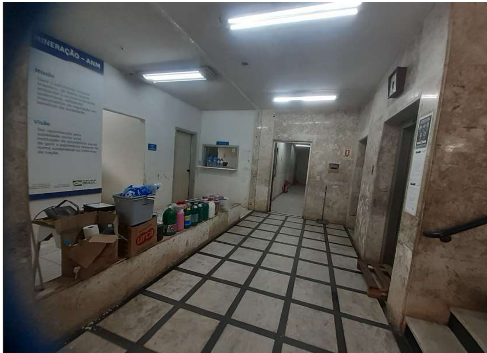
SAGUÃO DE ENTRADA/ ÁREA DO ELEVADOR
