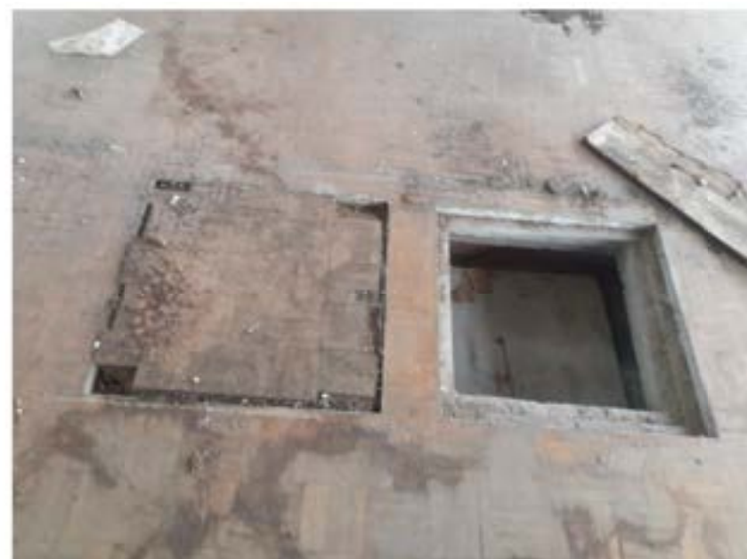
SALÃO DO 6º PAVIMENTO - DETALHES
