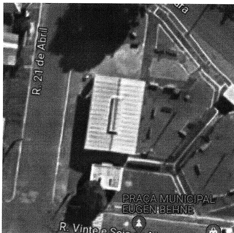
Figura 1: Pavilhão da praça Eugen Behne
