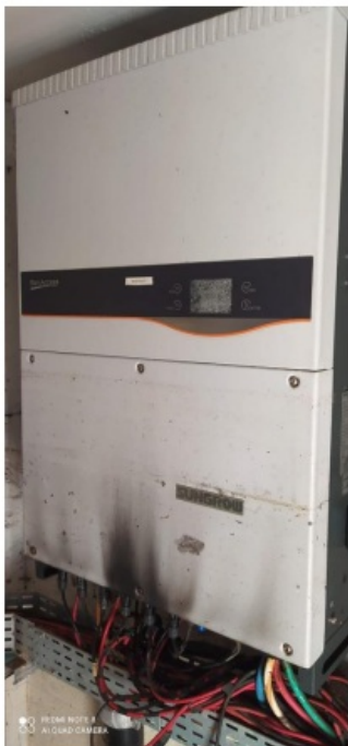
Foto 3: Inversores 1 (com a tampa arrancada provavelmente em razão do curto-circuito), 2 e 3, respectivamente.
