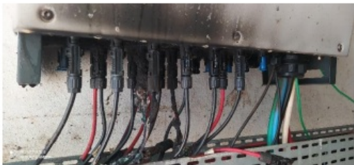
Foto 4: Conectores tipo MC4 dos cabos de corrente contínua que chegam das placas solares.
