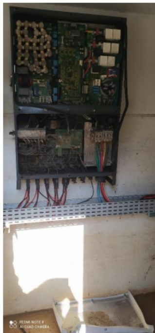
Foto 3: Inversores 1 (com a tampa arrancada provavelmente em razão do curto-circuito), 2 e 3, respectivamente.
