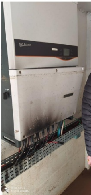
Foto 3: Inversores 1 (com a tampa arrancada provavelmente em razão do curto-circuito), 2 e 3, respectivamente.
