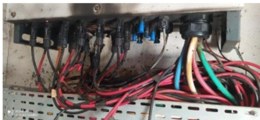
Foto 4: Conectores tipo MC4 dos cabos de corrente contínua que chegam das placas solares.
