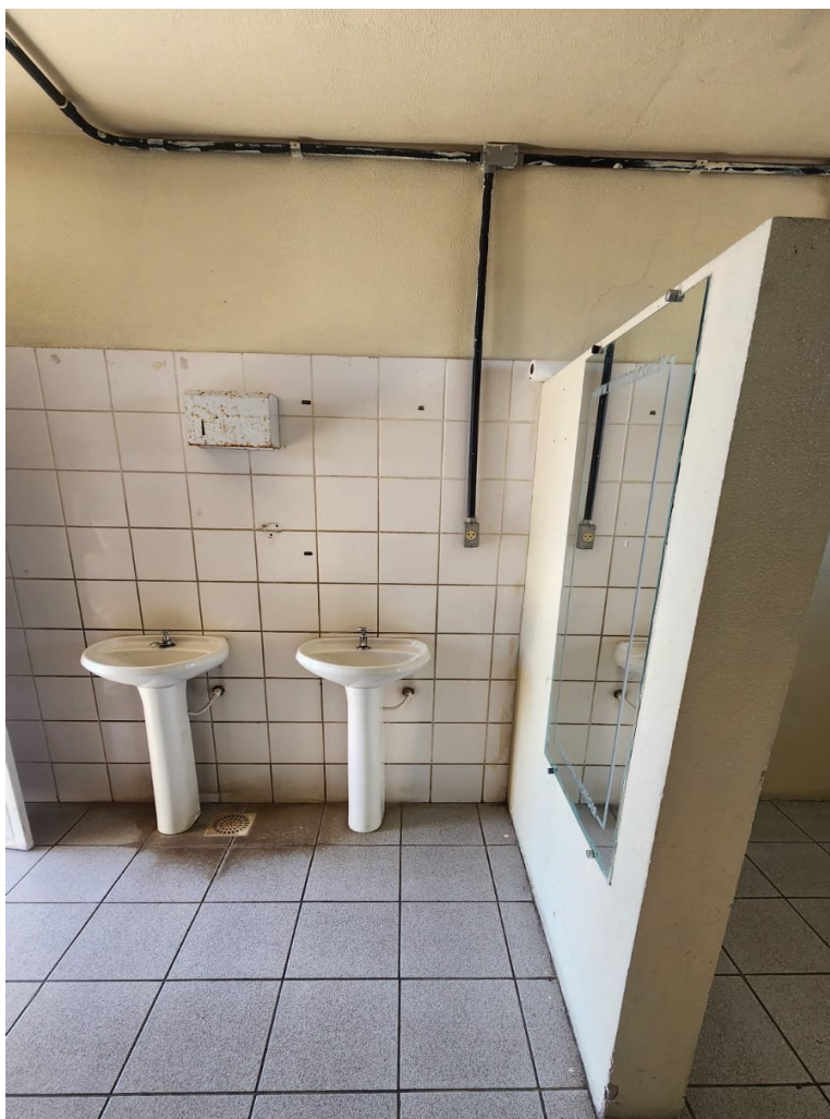
Figura 5: Pias dos banheiros a serem removidas.
