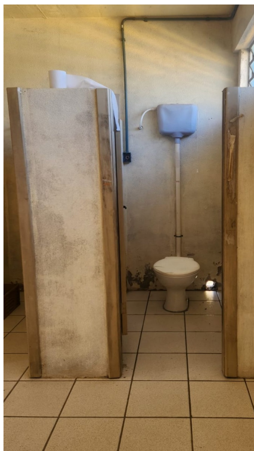
Figura 3: Cabines de sanitários a serem demolidas e reconstruídas.
