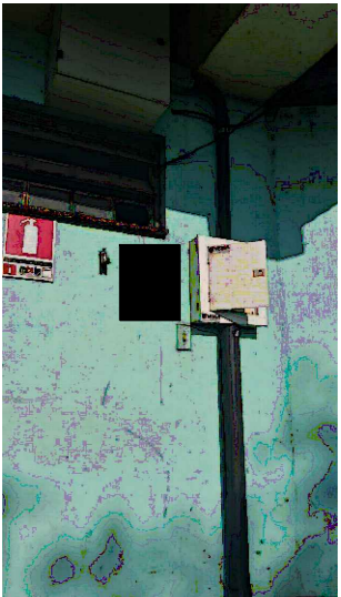
Tomada e Plug trifásica de 32 A
