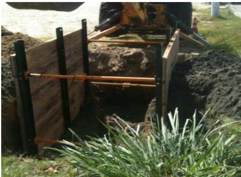
Vala com escoramento das laterais, devidamente dimensionado para o solo e profundidade local
