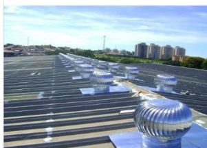
Exaustor Eólico Completo 24 Polegadas Instalação em telhado
