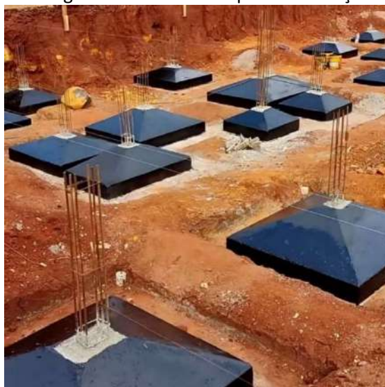
Imagem 10: Imagem ilustrativa da impermeabilização de sapatas
