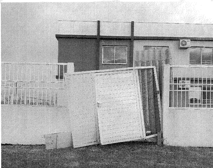
Figura 2: Portão de acesso PA-2
