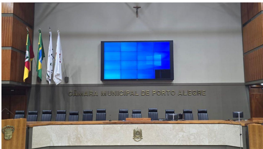
Imagem 01 - Situação do telão Plenário Otávio Rocha, obsoleto e com uma tela quebrada.
