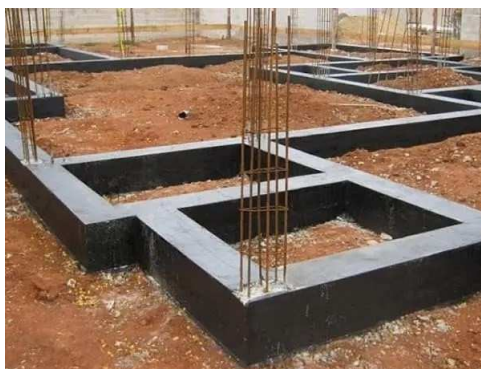
Imagem 06 – Impermeabilização da viga baldrame
