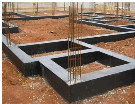
Imagem 06 – Impermeabilização da viga baldrame
