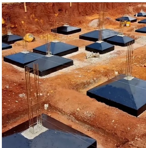
Imagem 06 – Impermeabilização da fundação
