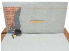
Nas alvenarias em bloco cerâmico, após chapisco, deverá ser aplicado camada de emboço, para recebimento de revestimento cerâmico, executado em argamassa de traço 1:2:8, com espessura de 20mm e execução de taliscas.
