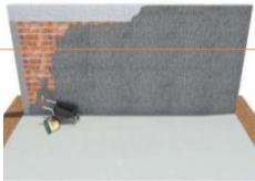
As alvenarias em bloco cerâmico, internas e externas deverão receber chapisco aplicado com colher de pedreiro em alvenaria (com e sem presença de vãos) com traço de 1:4, preparado em betoneira de 400l.
