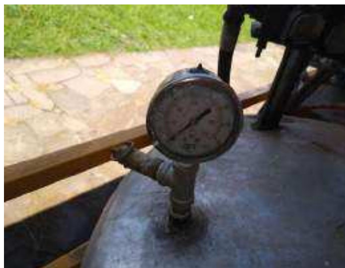
Válv. de segurança e manômetro
