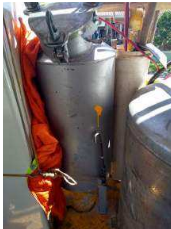
Vista frontal do tanque
