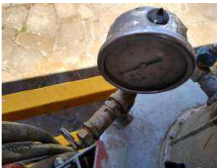
Válv. de segurança e manômetro
