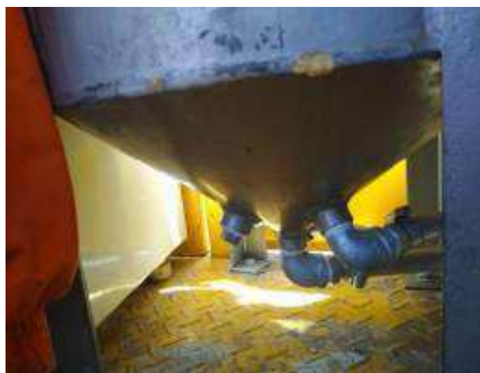
Tampo inferior e solda do tampo
