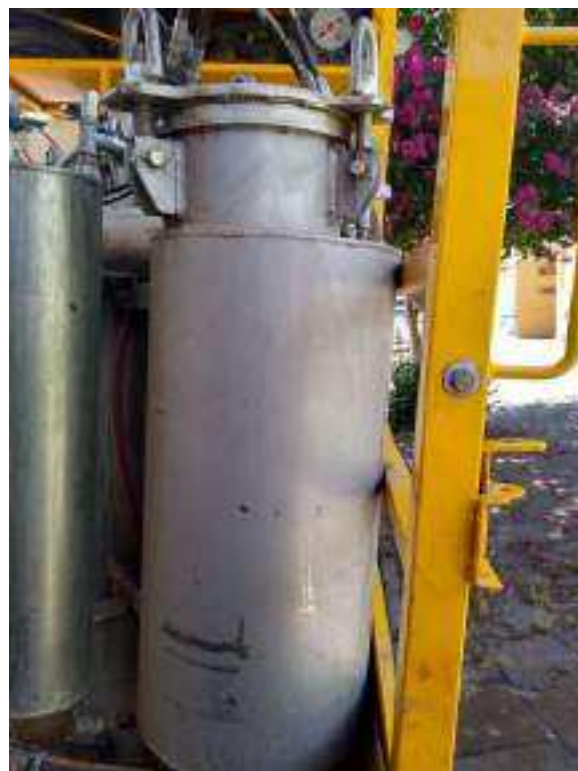
Vista frontal do tanque
