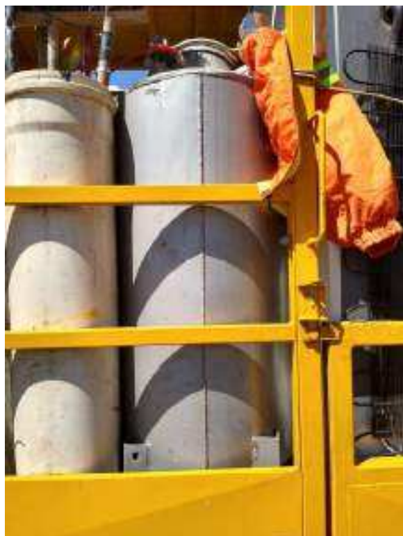
Vista traseira do tanque
