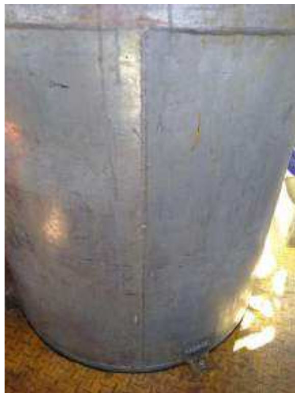
Solda no costado
