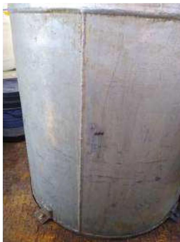
Solda vertical do costado e fixação
