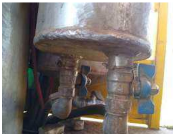
Solda do tampo inferior e saída do solvente
