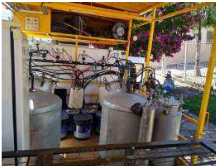
Local de instalação dos tanques
