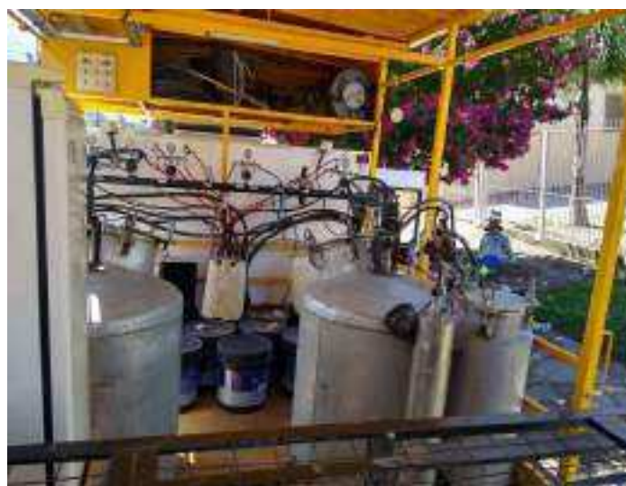
Vista interna do caminhão
