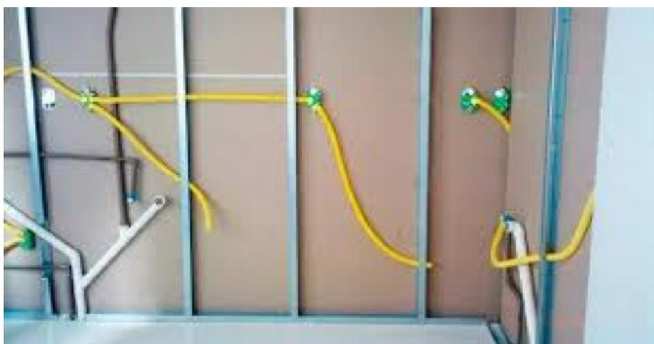
Imagem ilustrativa da execução das instalações elétrica após a execução da primeira camada de gesso acartonado em uma das faces
