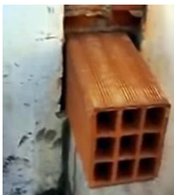
Amarração entre alvenaria nova e existente
