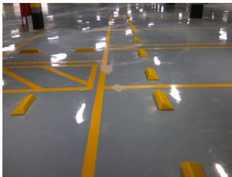
Exemplo de sinalização viária com tinta epóxi na cor amarela
