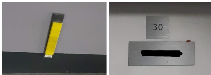
Protetores de para-choque e placas de identificação a serem removidos
